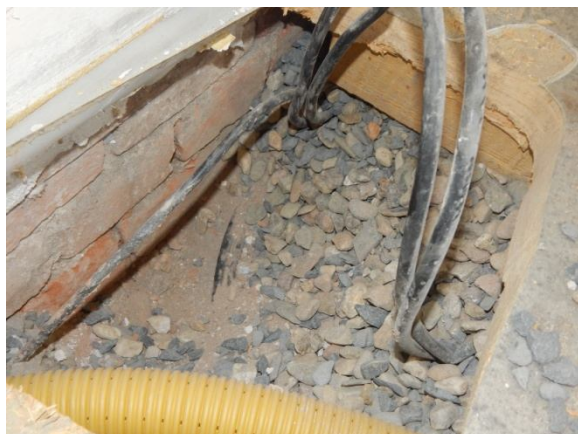
podlaha pod pravou částí
