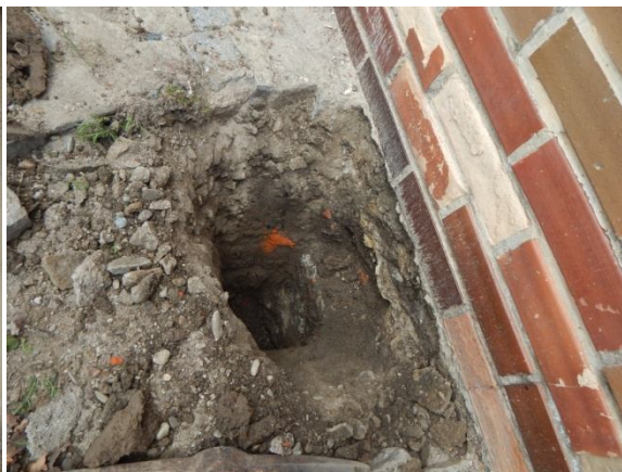
základ pod obvodovou stěnou
