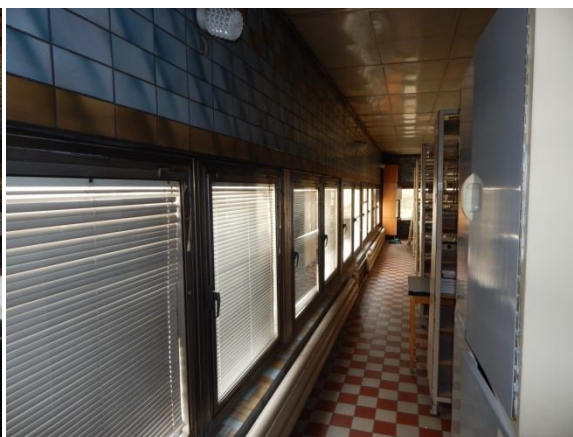
ocelové sloupky mezi okny
