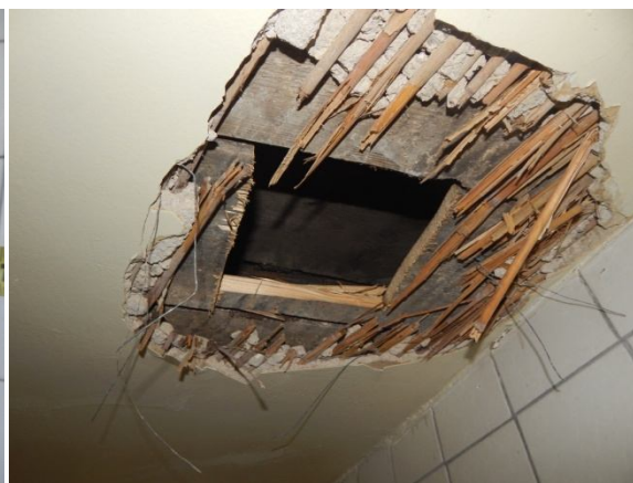
konstrukce stropu (střechy)
