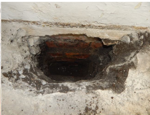
Spuštění vnitřní stěny pod podlahu
