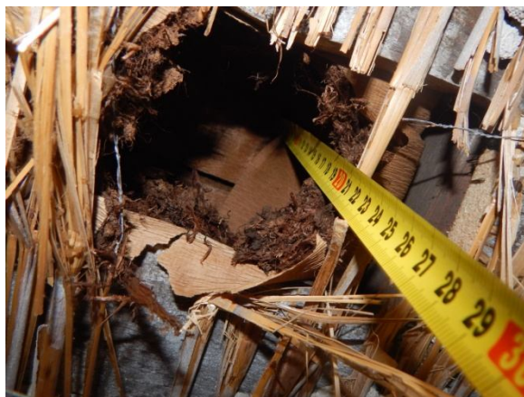
Stropní konstrukce ze spod
