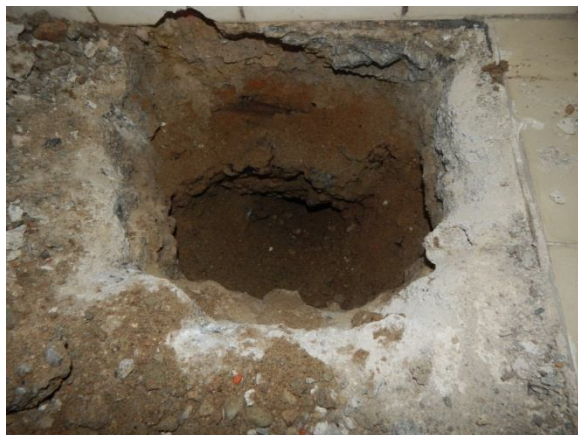
základ pod vnitřní stěnou
