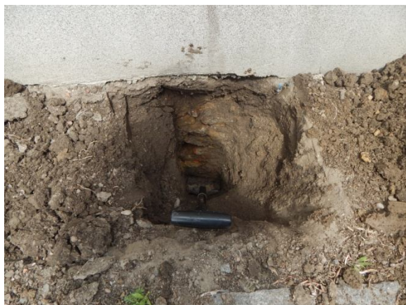
základ pod obvodovou stěnou
