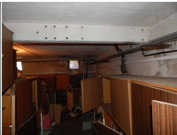
nosník ve sklepení pod stěnou
