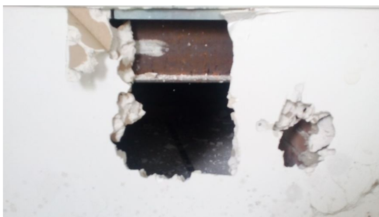
konstrukce pod chladícím boxem (ocel. nosníky)
