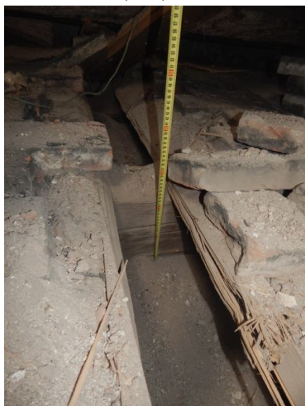
strop nad 1NP (z půdy)
