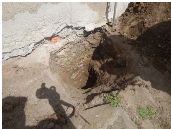
základ pod pravou částí
