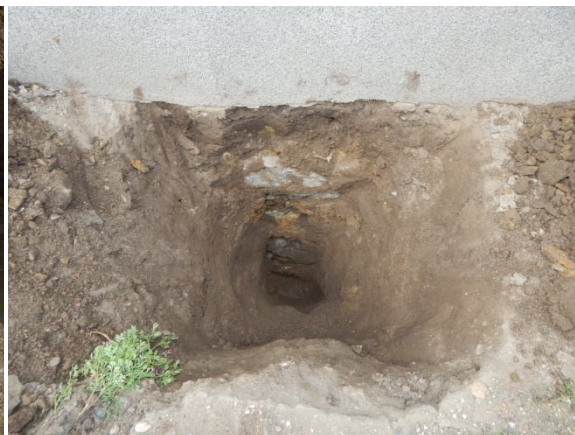
základ pod levou částí
