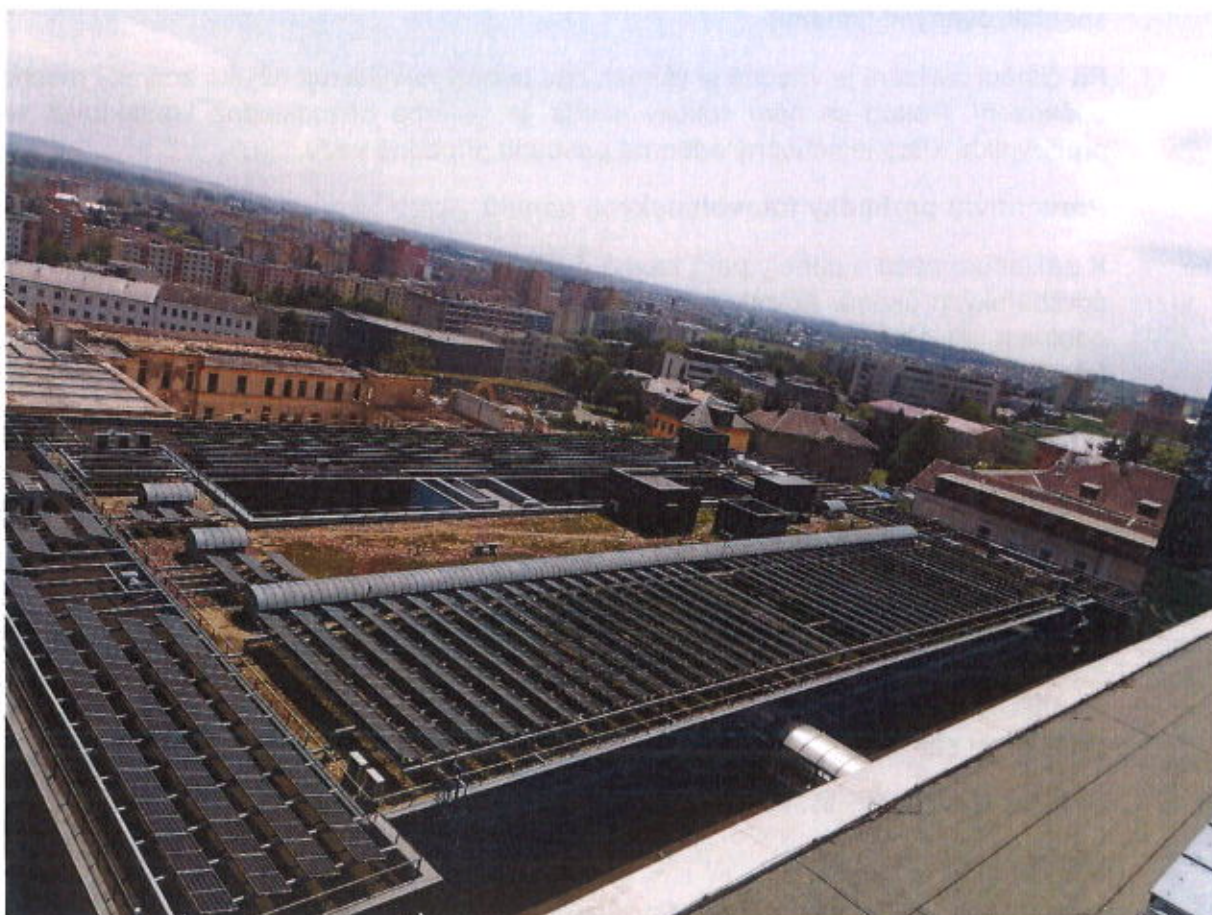
Obrázek č. 1 – FV panely HUASUN HS-B120 DS400-B umístěné na střeše budovy A
