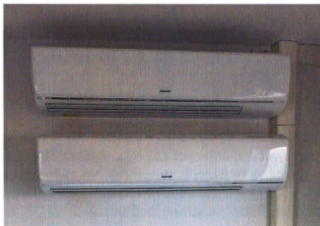
Obrázek č. 12 – vnitřní jednotka klimatizace
