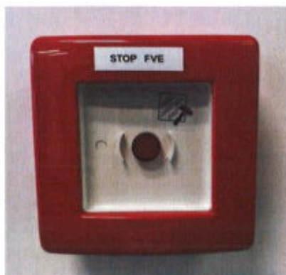
Obrázek č. 16 – FVE1 CENTRAL STOP s kladívkem pro rozbití skla
