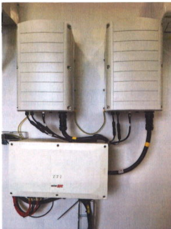
Obrázek č. 7 – Střídače FVE1b
