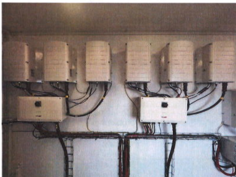
Obrázek č. 6 – Střídače FVE1a
