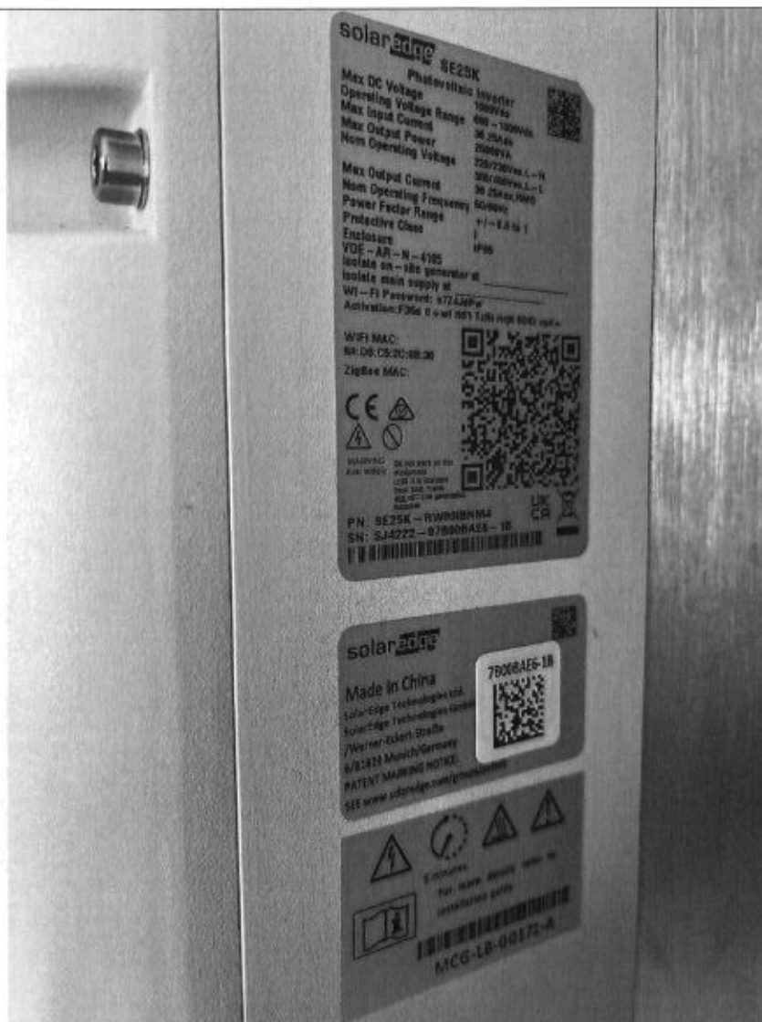
Obr. 5: Štítek střídače FVE SE25K na budově Y
