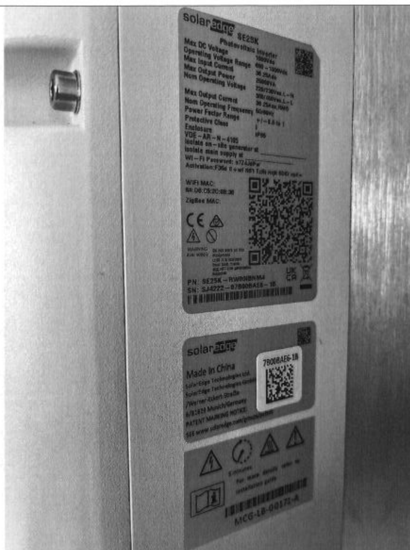
Obr. 5: Štítek střídače FVE SE25K na budově Y
