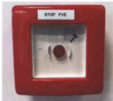
Obrázek č. 12 –STOP FVE tlačítko
