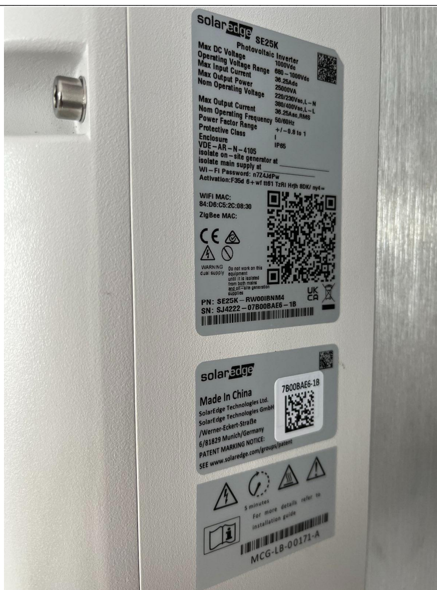
Obr. 5: Štítek střídače FVE SE25K na budově Y
