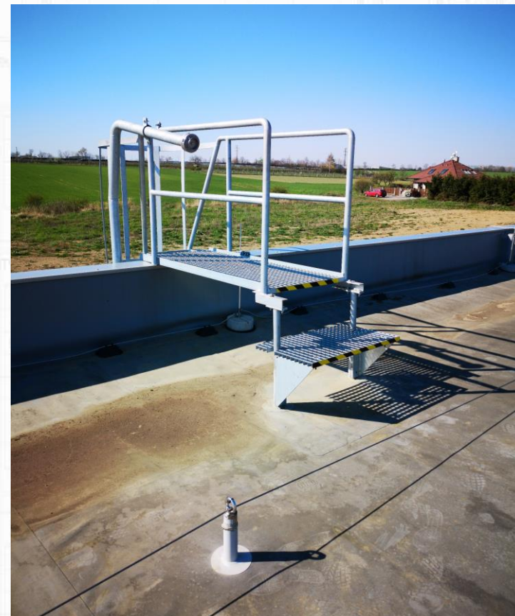
Příklad správně vyhotoveného výlezu. Disponuje lávkou a zábradlím a vyvádí z rizikové zóny
