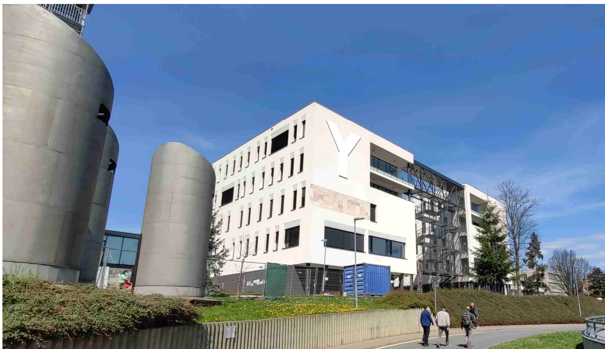
Obrázek č. 3.1.3: Pohled na řešený objekt a střechu objektu
