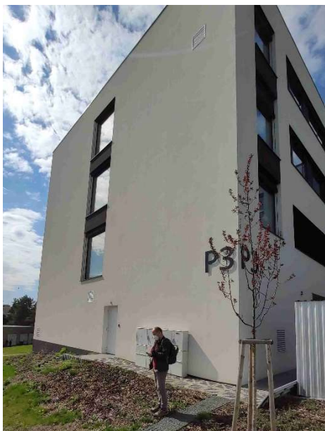
Obrázek č. 3.1.2: Pohled na řešený objekt P a střechu objektu
