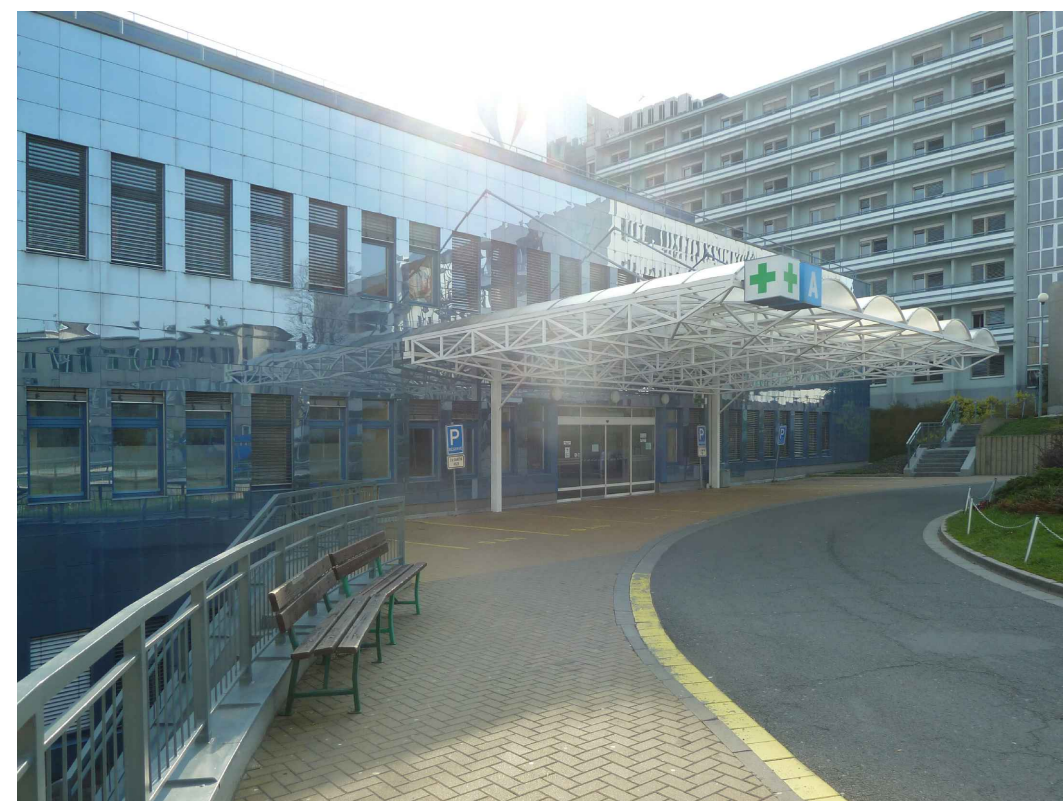
Budova A - Vyšetřovací a operační centrum - pohled východní - hlavní vstup
