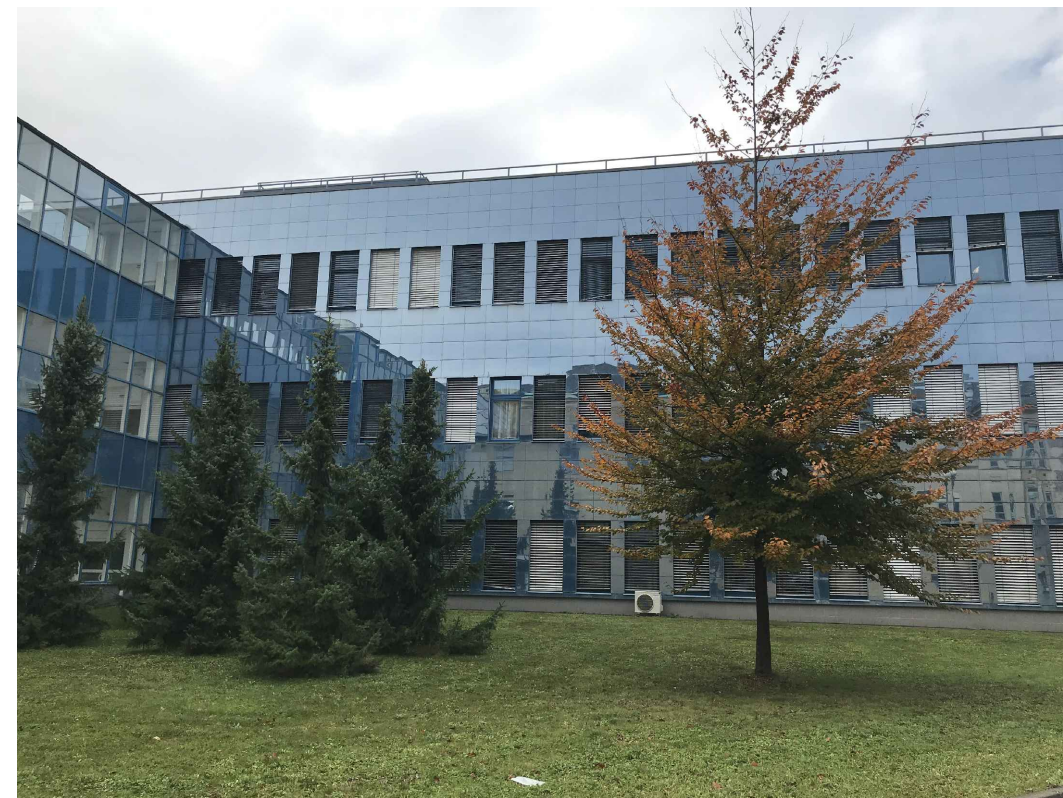
Budova A - Vyšetřovací a operační centrum - pohled jižní z vnitrobloku
