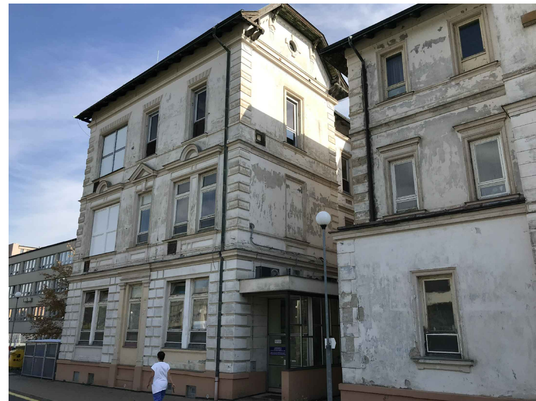
Budova E - Oční klinika, Klinika otorinolaryngologie a chirurgie hlavy a krku - pohled ze západu - hlavní vstup
