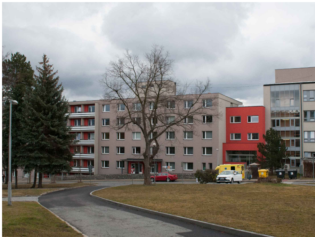
Budova H - Onkologická klinika, Klinika plicních nemocí a tuberkulózy - pohled z východu
