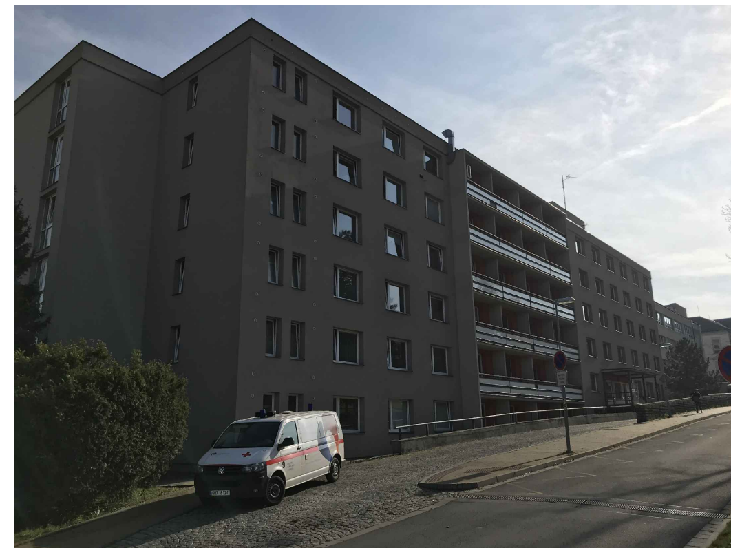
Budova H - Onkologická klinika, Klinika plicních nemocí a tuberkulózy - pohled ze severozápadu
