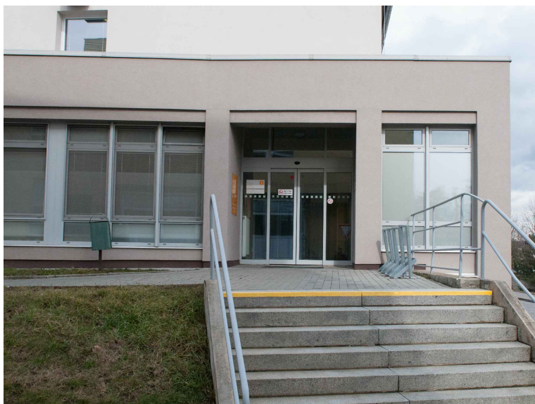
Budova I - Oddělení klinické biochemie a imunogenetiky - pohled z jihu - hlavní vstup
