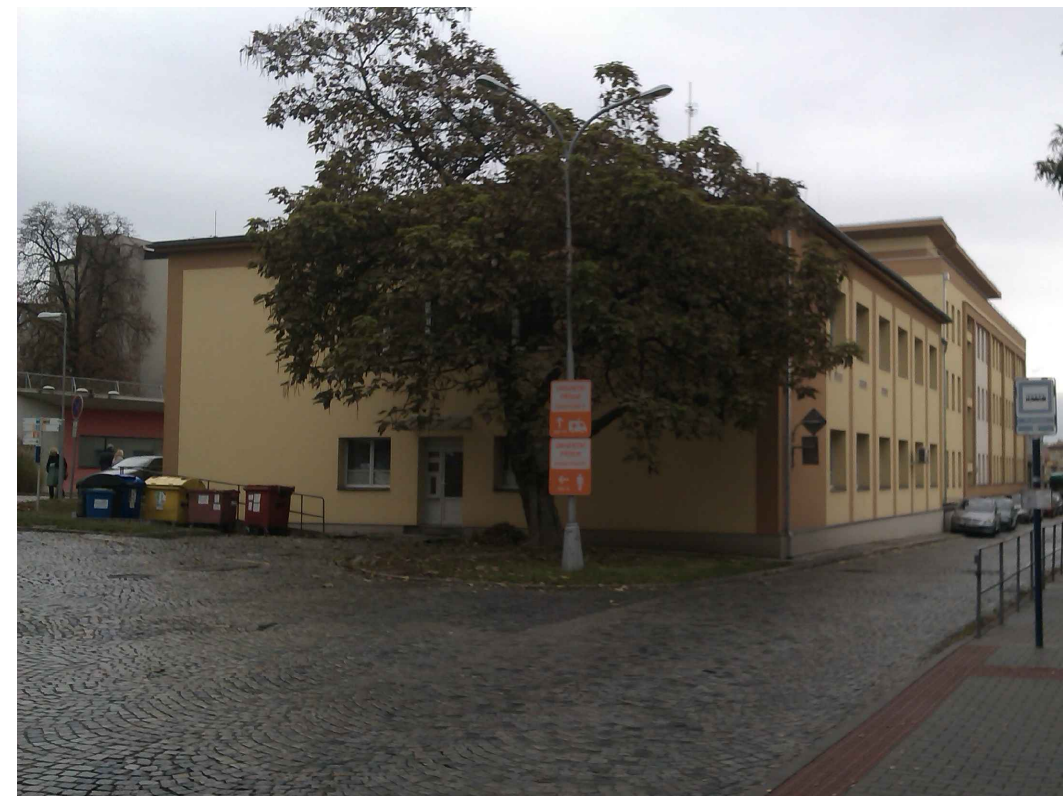
Budova J - III. Interní klinika - nefrologická, revmatologická a endokrinologická, Klinika nukleární medicíny - pohled ze severu
