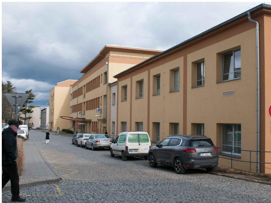
Budova J - III. Interní klinika - nefrologická, revmatologická a endokrinologická, Klinika nukleární medicíny - pohled z jihozápadu
