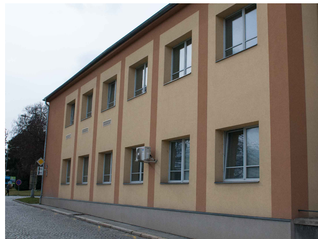
Budova J - III. Interní klinika - nefrologická, revmatologická a endokrinologická, Klinika nukleární medicíny - pohled z východu
