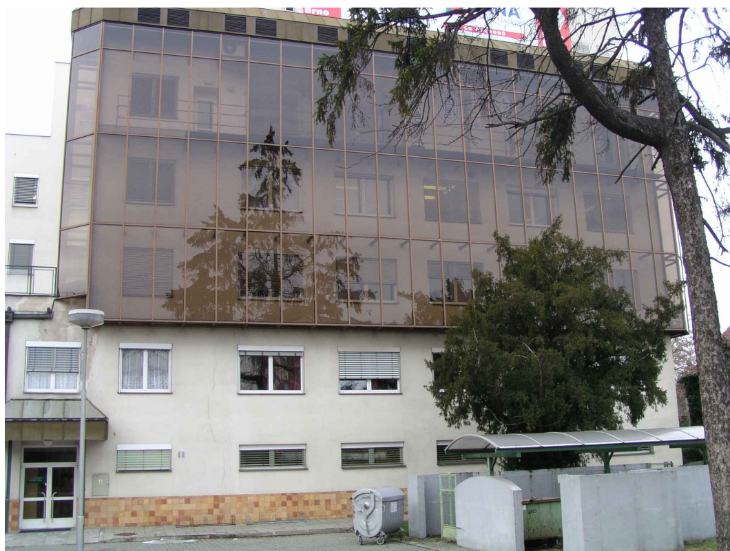
Budova L - Transfúzní oddělení - pohled z jihovýchodu
