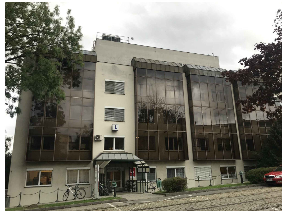
Budova L - Transfúzní oddělení - pohled ze severozápadu - hlavní vstup
