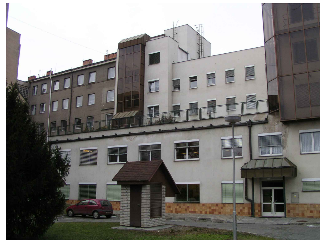
Budova L - Transfúzní oddělení - pohled z jihu
