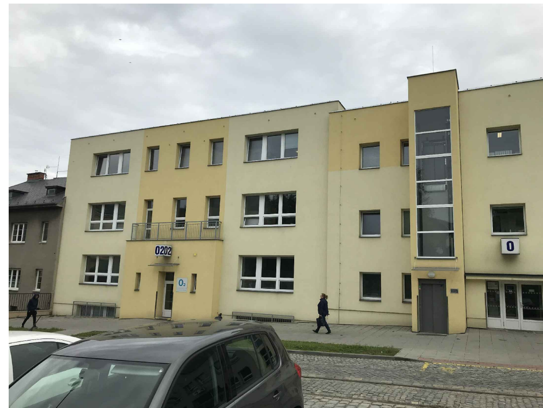
Budova O - Klinika tělovýchovného lékařství a kardiovaskulární rehabilitace, Úsek informačních technologií - pohled ze západu
