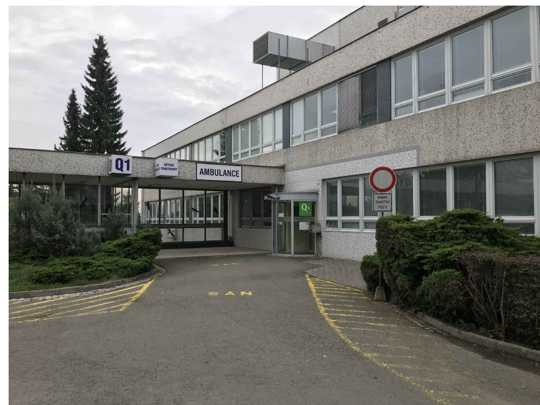
Budova Q - Dětská klinika - pohled ze západu
