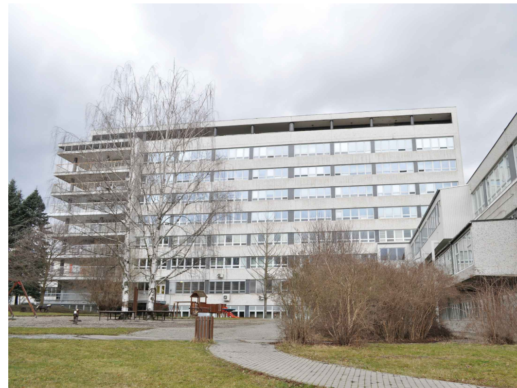
Budova Q - Dětská klinika - pohled z jihovýchodu
