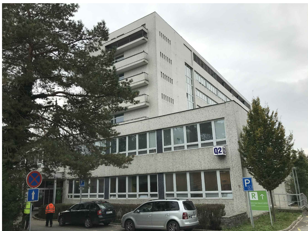
Budova Q - Dětská klinika - pohled z východu
