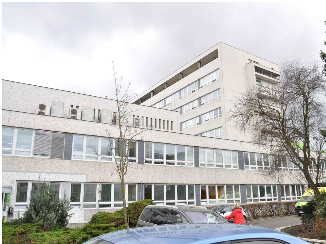
Budova Q - Dětská klinika - pohled ze severovýchodu
