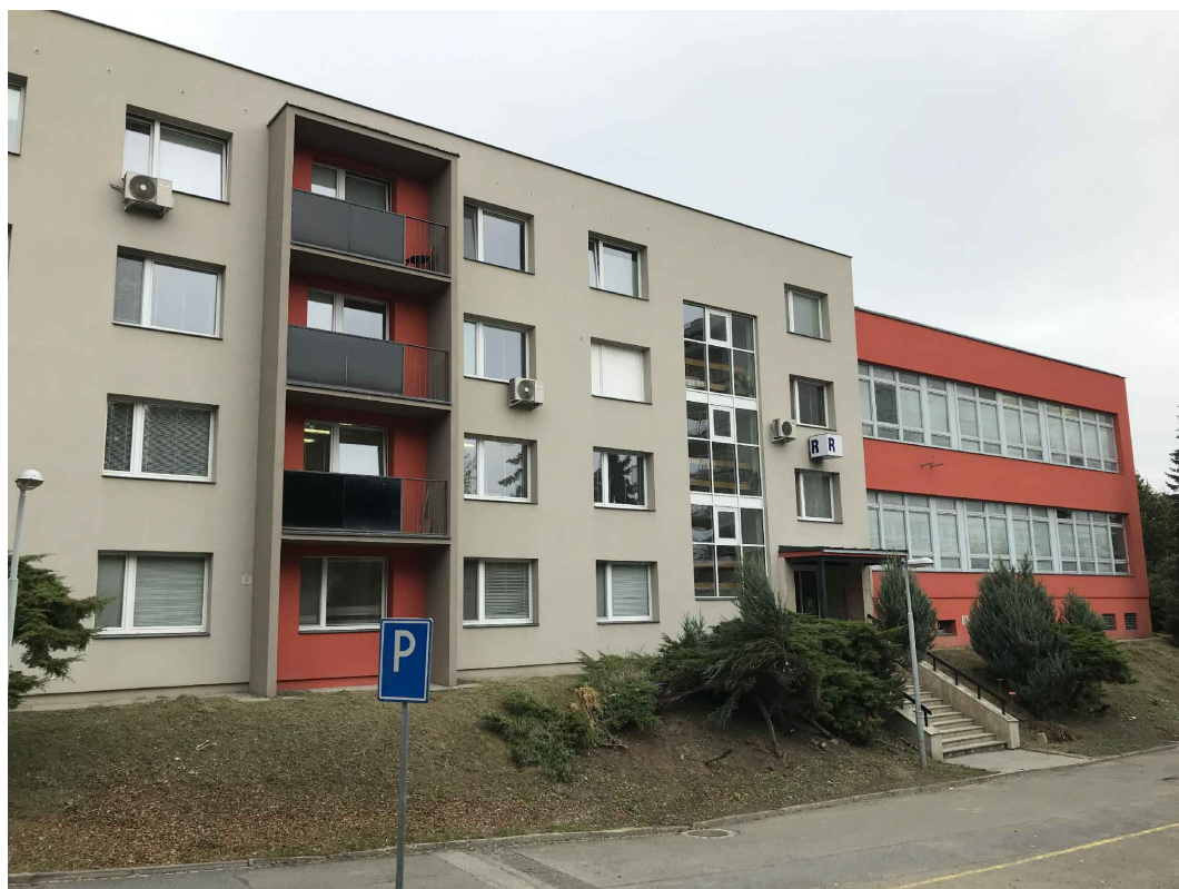
Budova R - Klinika ústní, čelistní a obličejové chirurgie - pohled z jihu
