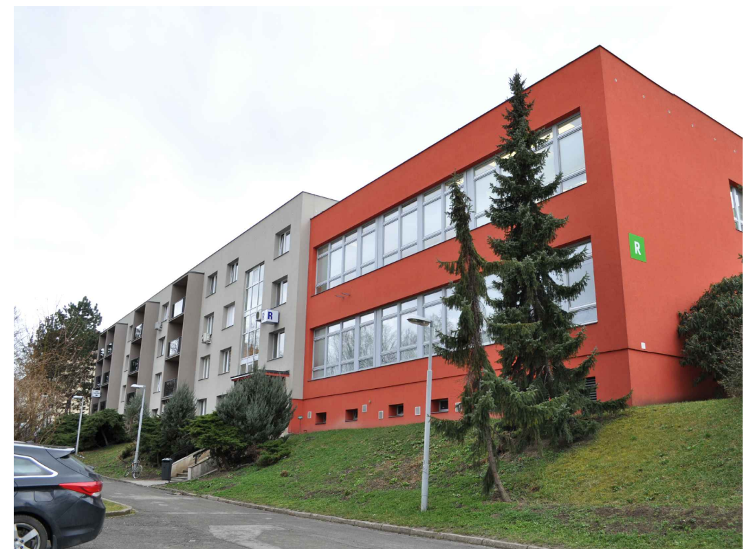
Budova R - Klinika ústní, čelistní a obličejové chirurgie - pohled z východu
