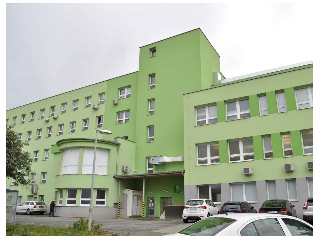
Budova S - Ortopedická klinika - pohled z východu
