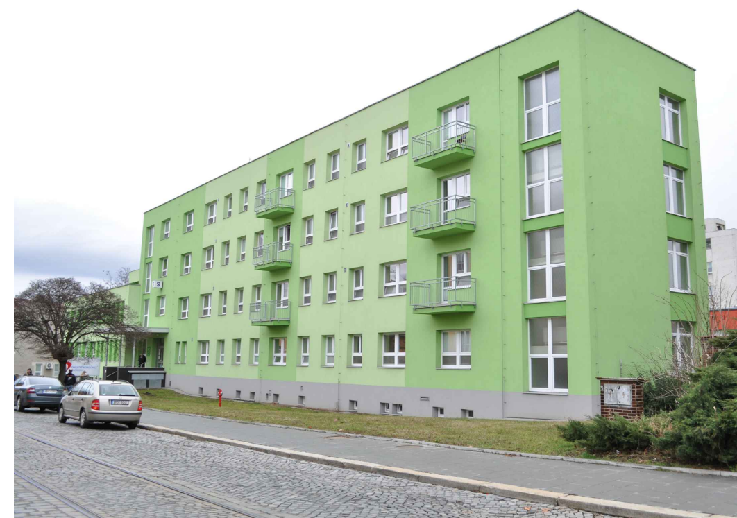
Budova S - Ortopedická klinika - pohled z jihozápadu
