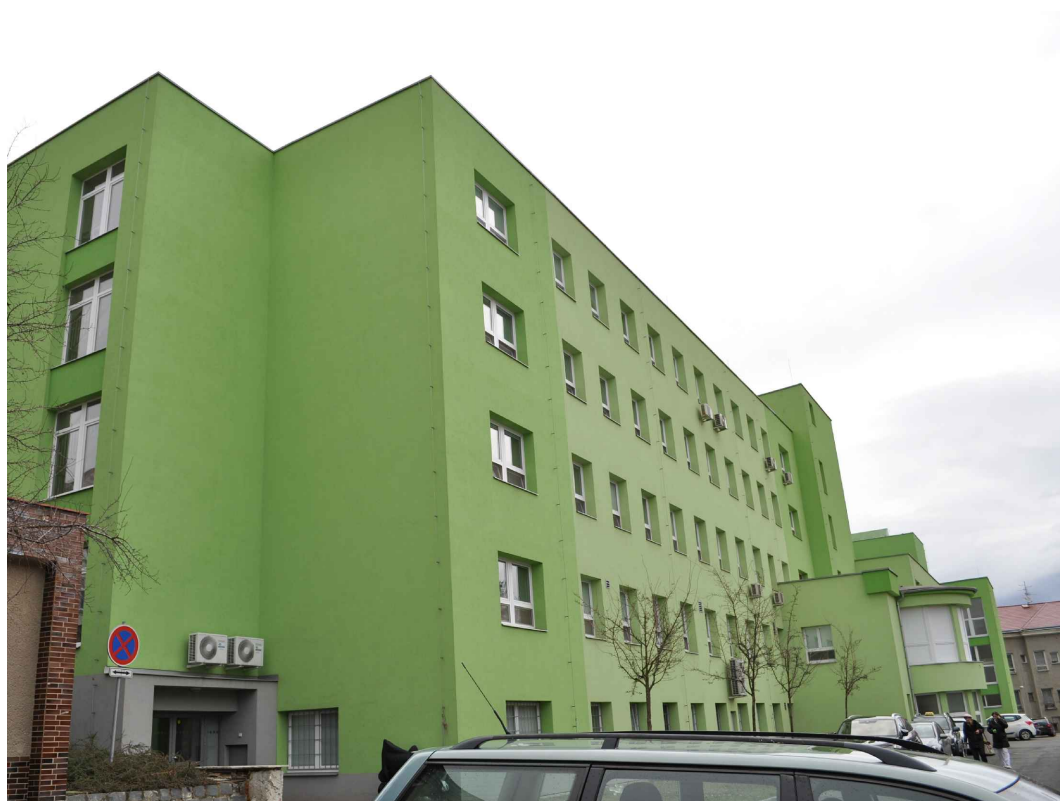
Budova S - Ortopedická klinika - pohled z jihu
