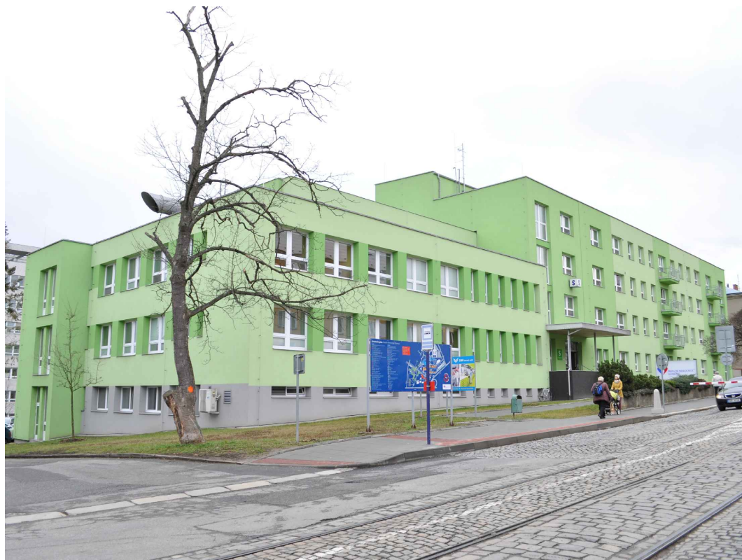
Budova S - Ortopedická klinika - pohled ze severu
