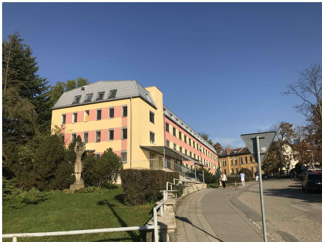
Budova U - Kliniky psychiatrie - pohled z jihu
