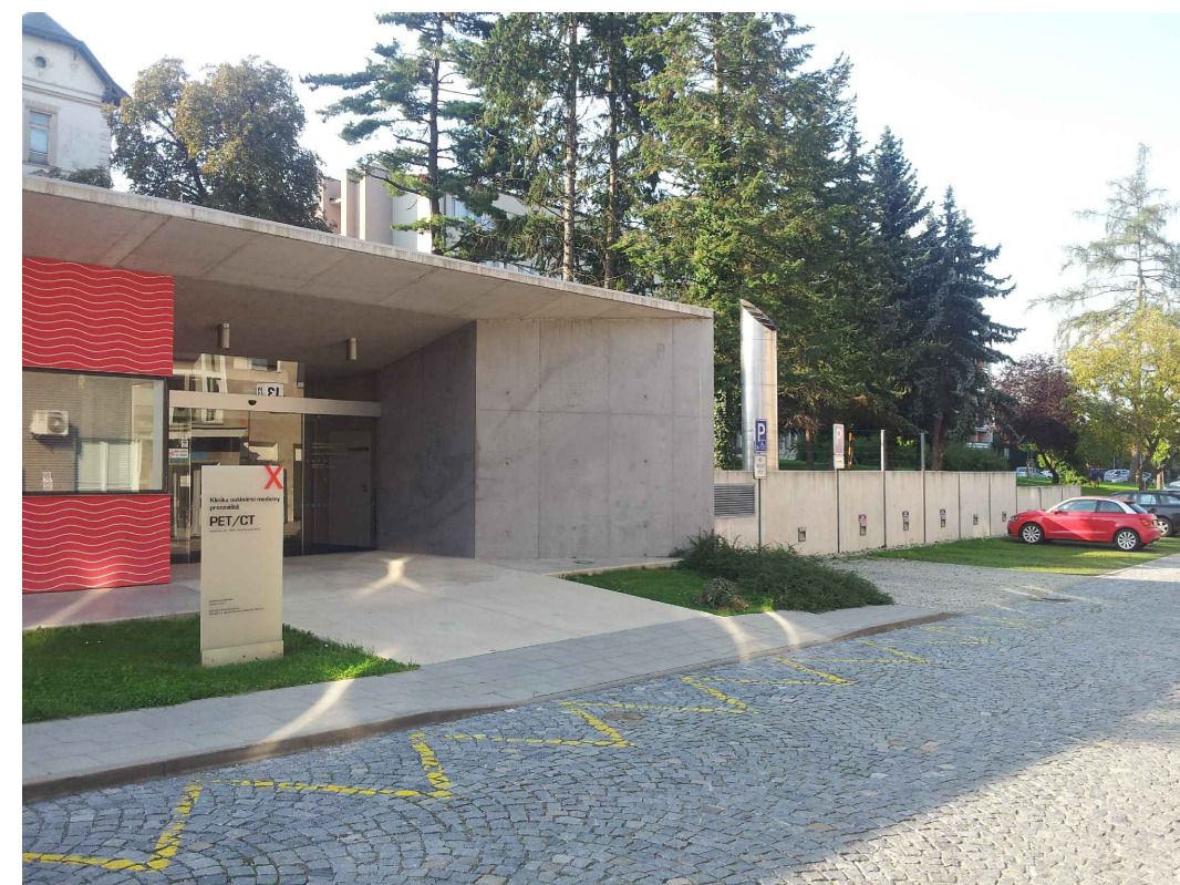
Budova X - Klinika nukleární medicíny - pohled z jihu
