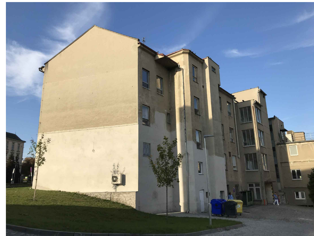
Budova N - sklady, šatny - pohled z jihu
