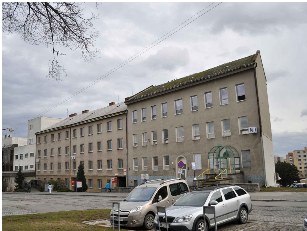
Budova N - sklady, šatny - pohled ze západu
