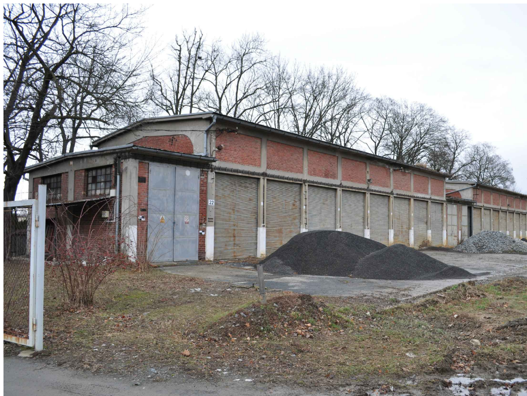
Budova QZC - garáž - pohled z jihu
