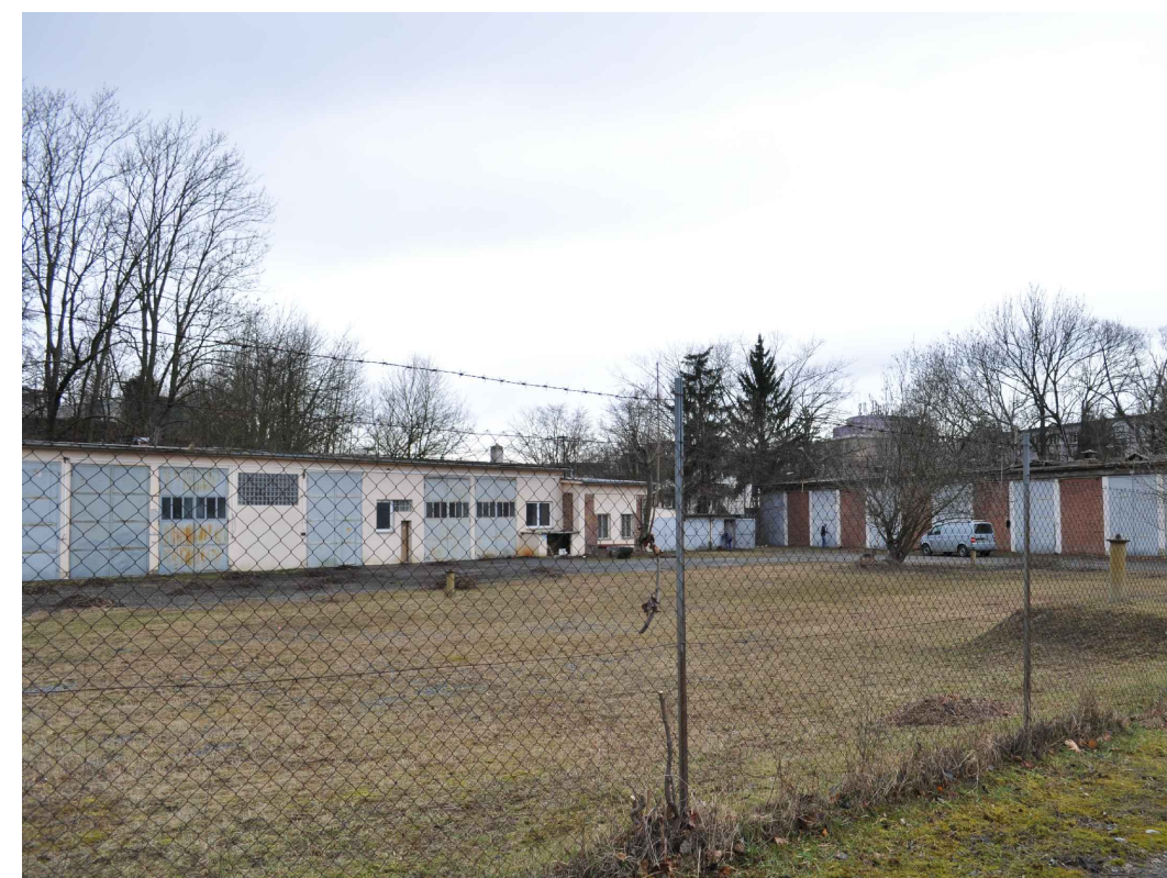
Budova QZH1 - garáž - pohled ze severu
