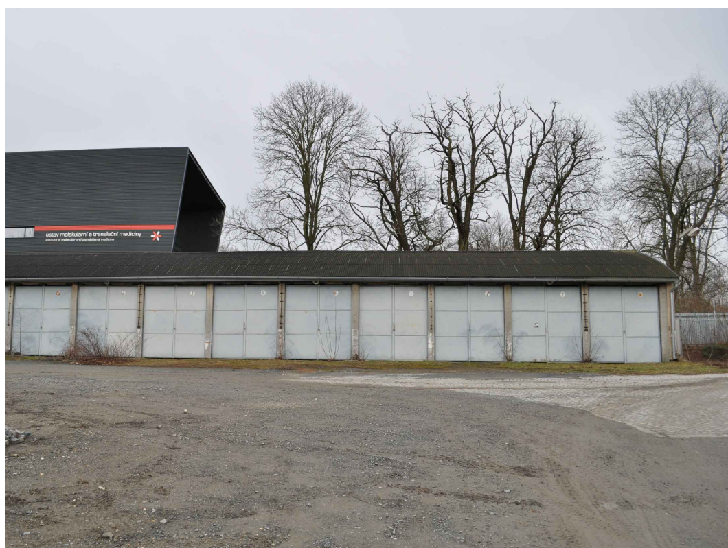
Budova QZE - garáž - pohled ze západu
