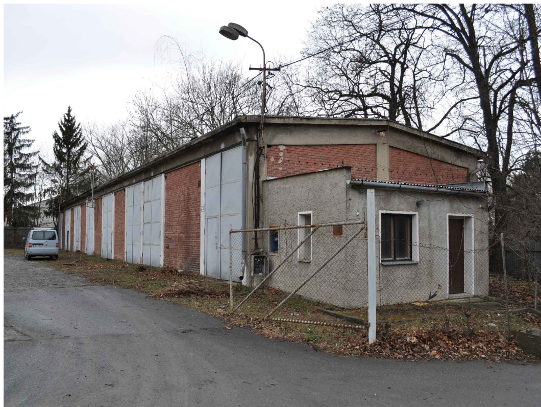
Budova QZI - garáž - pohled ze severu
