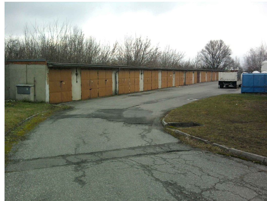
Budova QZL - garáž - pohled z jihu
