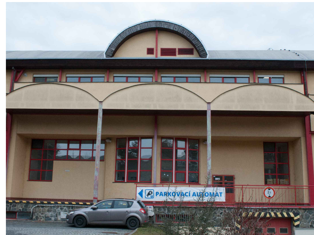
Budova WD - Stravovací provoz - pohled ze západu
