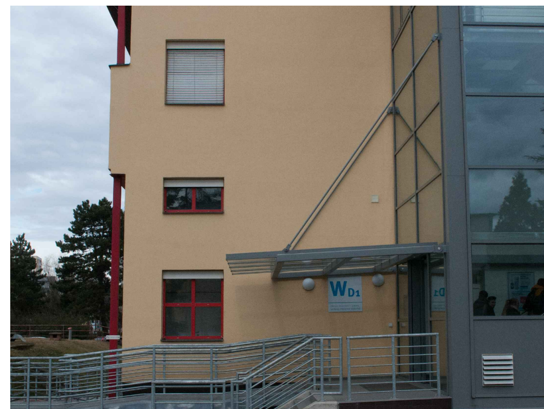
Budova WD - Stravovací provoz - pohled z jihu
