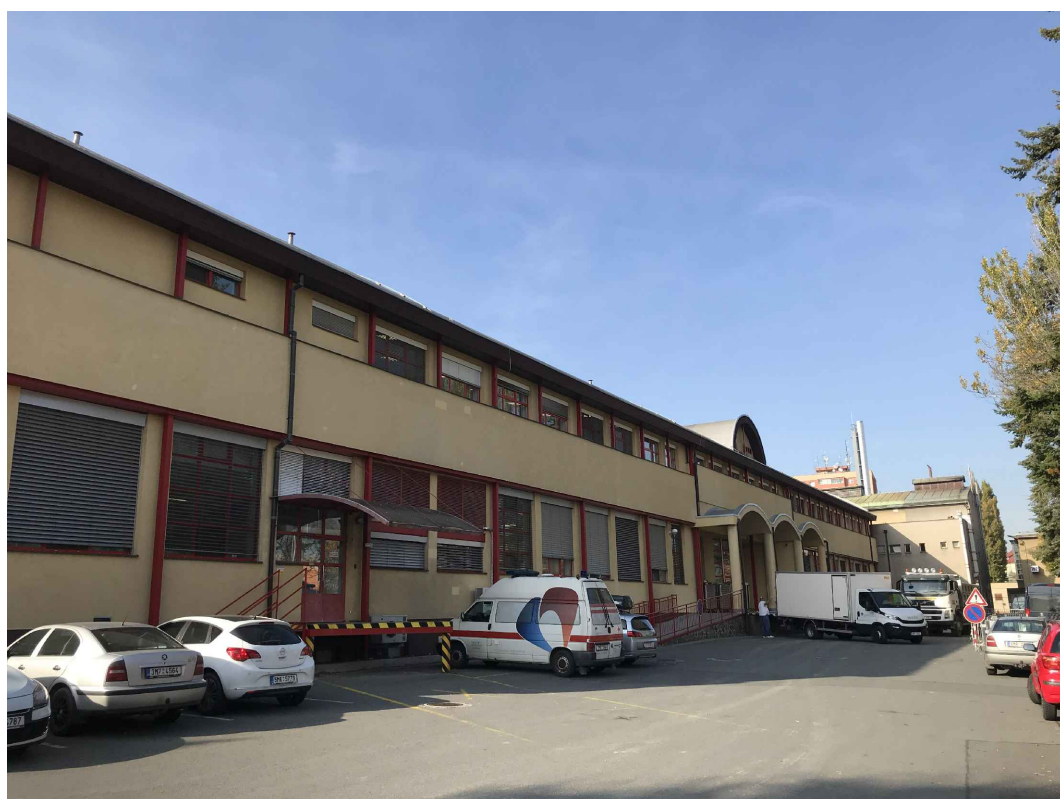
Budova WD - Stravovací provoz - pohled ze severovýchodu
