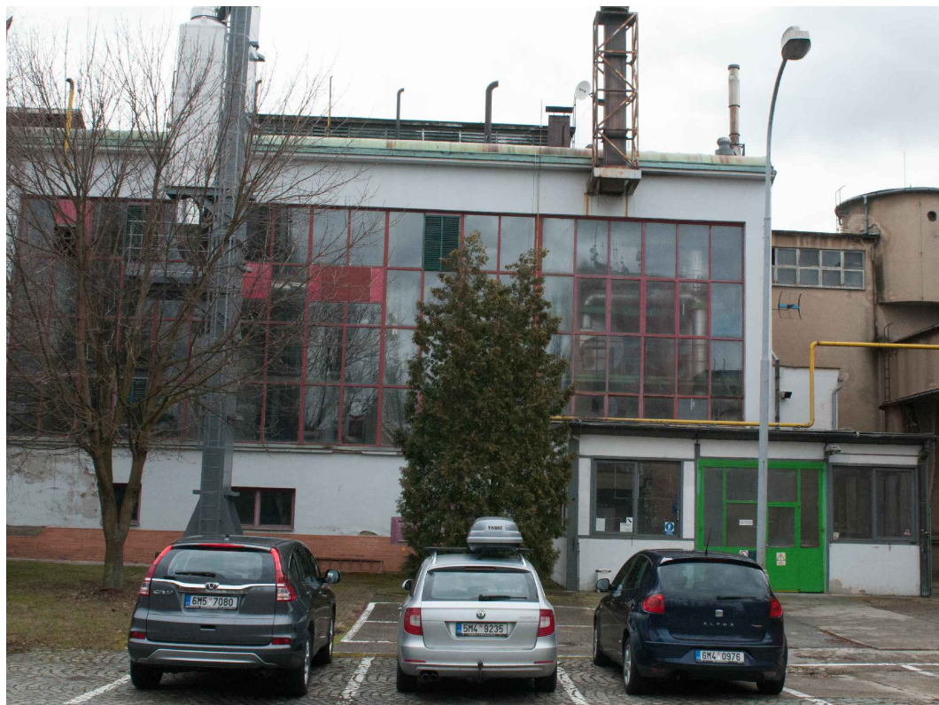
Budova WE - kotelna - pohled ze severu
