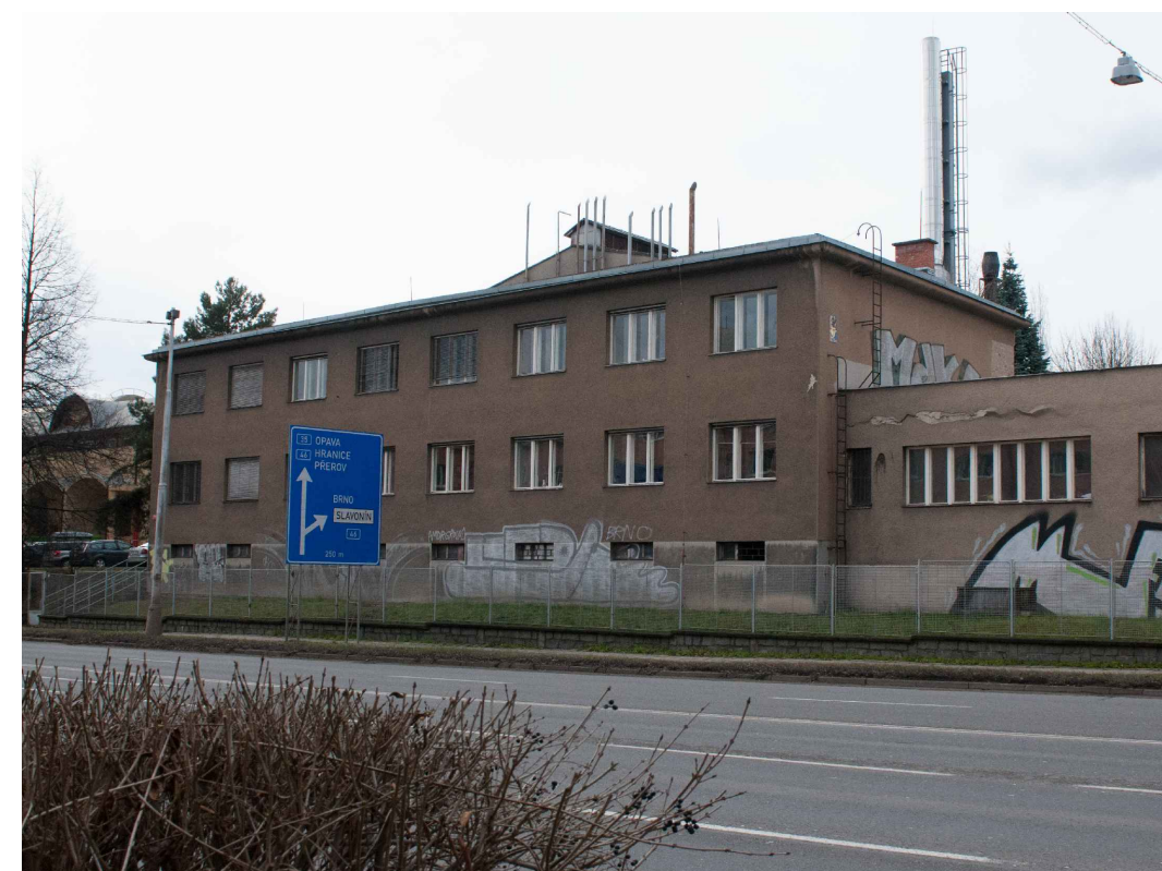
Budova WF - Obchodní úsek, ředitelství - pohled ze severovýchodu
