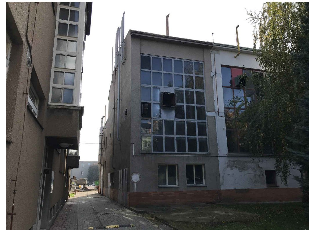
Budova WE - kotelna - pohled ze severu
