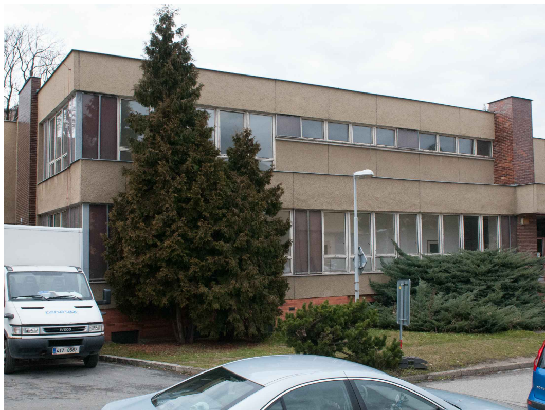
Budova WJ - sklady, prádelna - pohled ze severovýchodu
