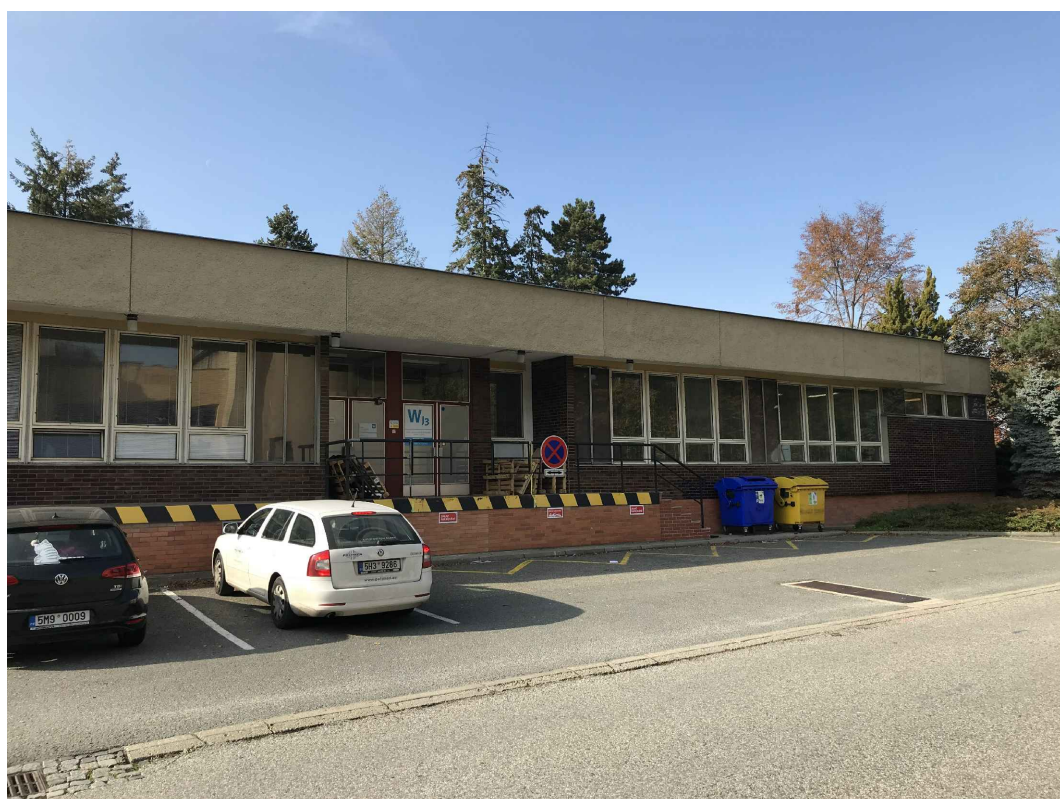
Budova WJ - sklady, prádelna - pohled ze severovýchodu
