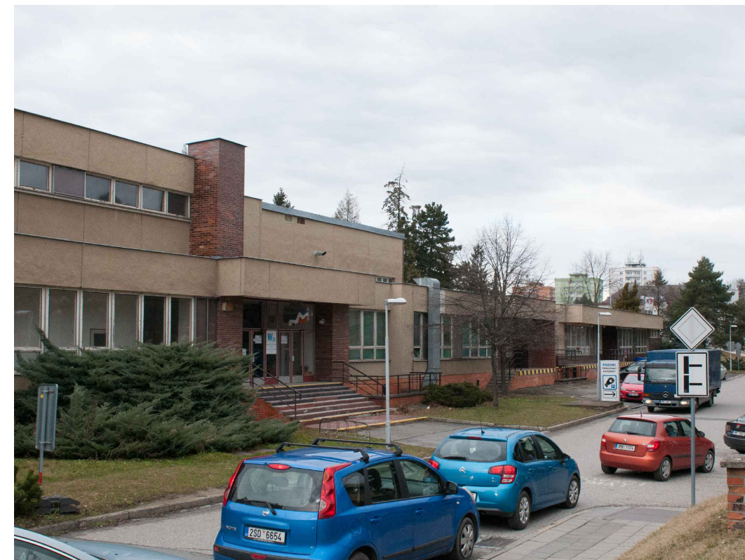
Budova WJ - sklady, prádelna - pohled ze severovýchodu
