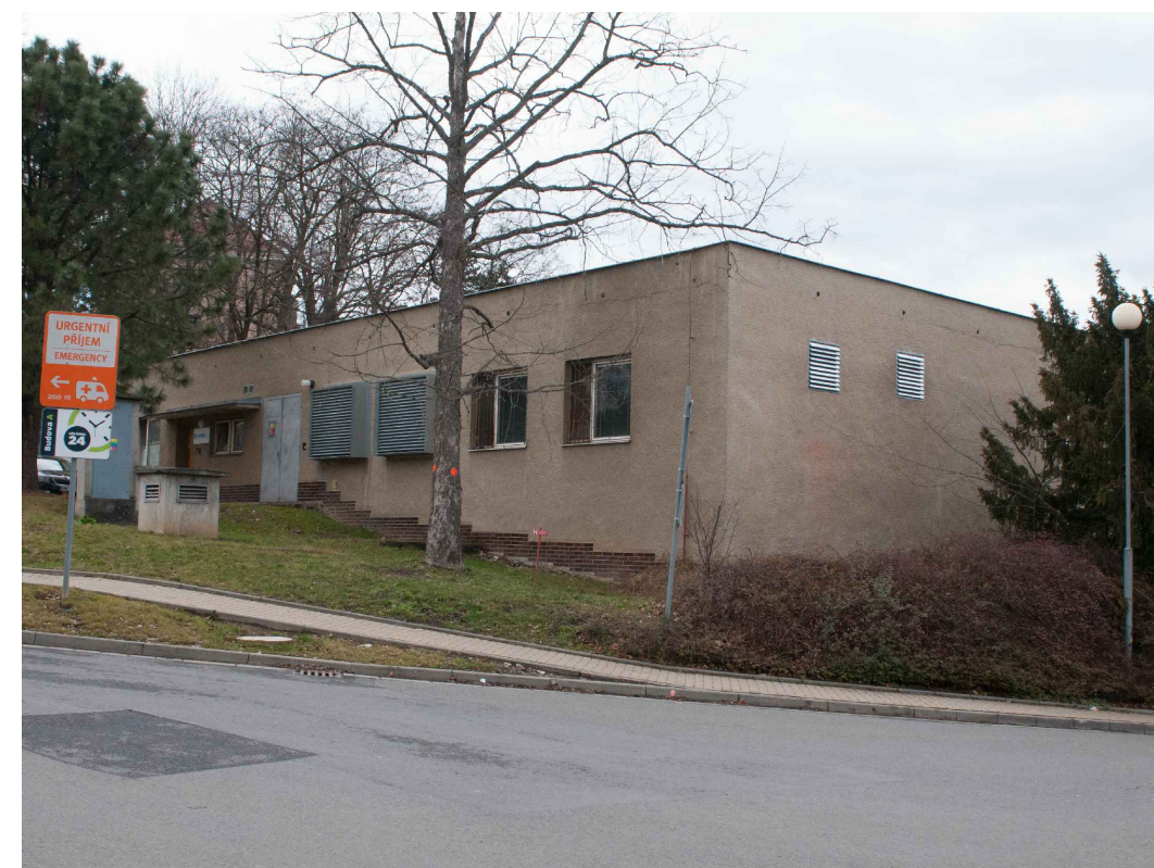
Budova WK - energoblok TS1 - pohled z jihu
