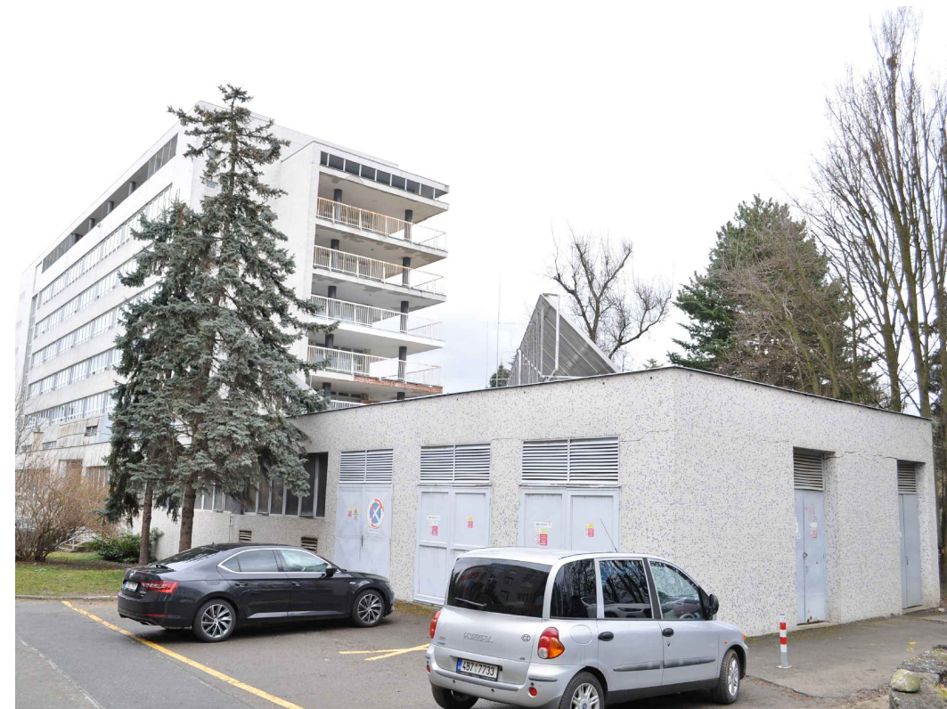
Budova WP - energoblok TS3 - pohled ze západu
