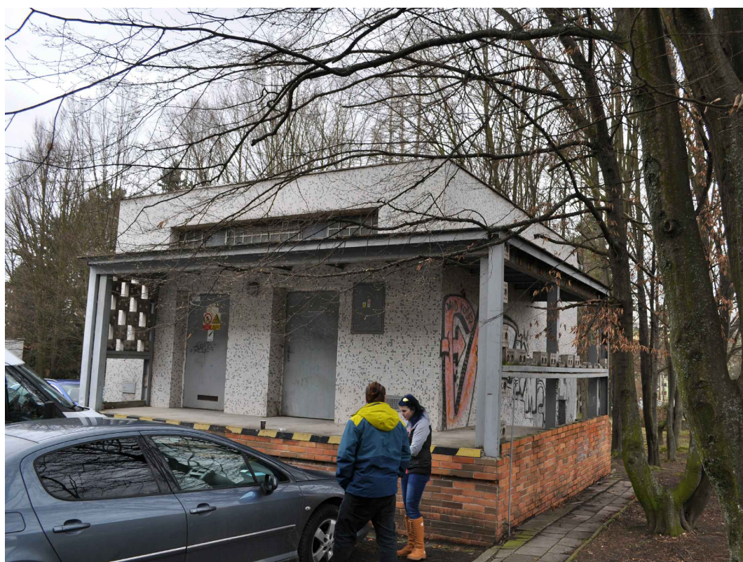
Budova WQ - kompresovna, rozvodovna - pohled ze západu
