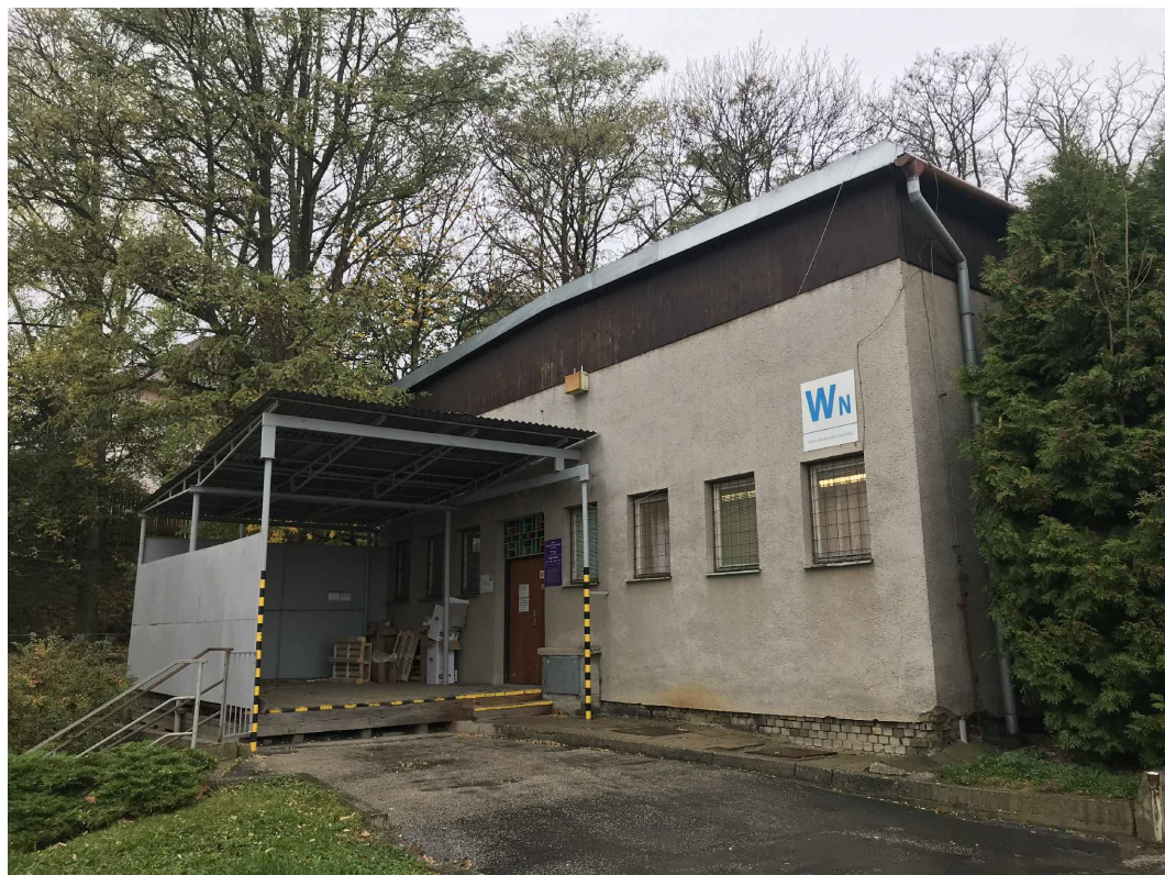
Budova WN - sklad - pohled z východu
