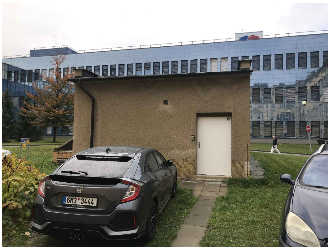
Budova WX - zázemí údržby VZT - pohled z východu
