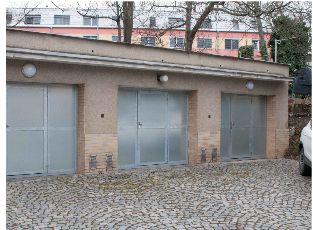
Budova WU - garáže - pohled ze severu
