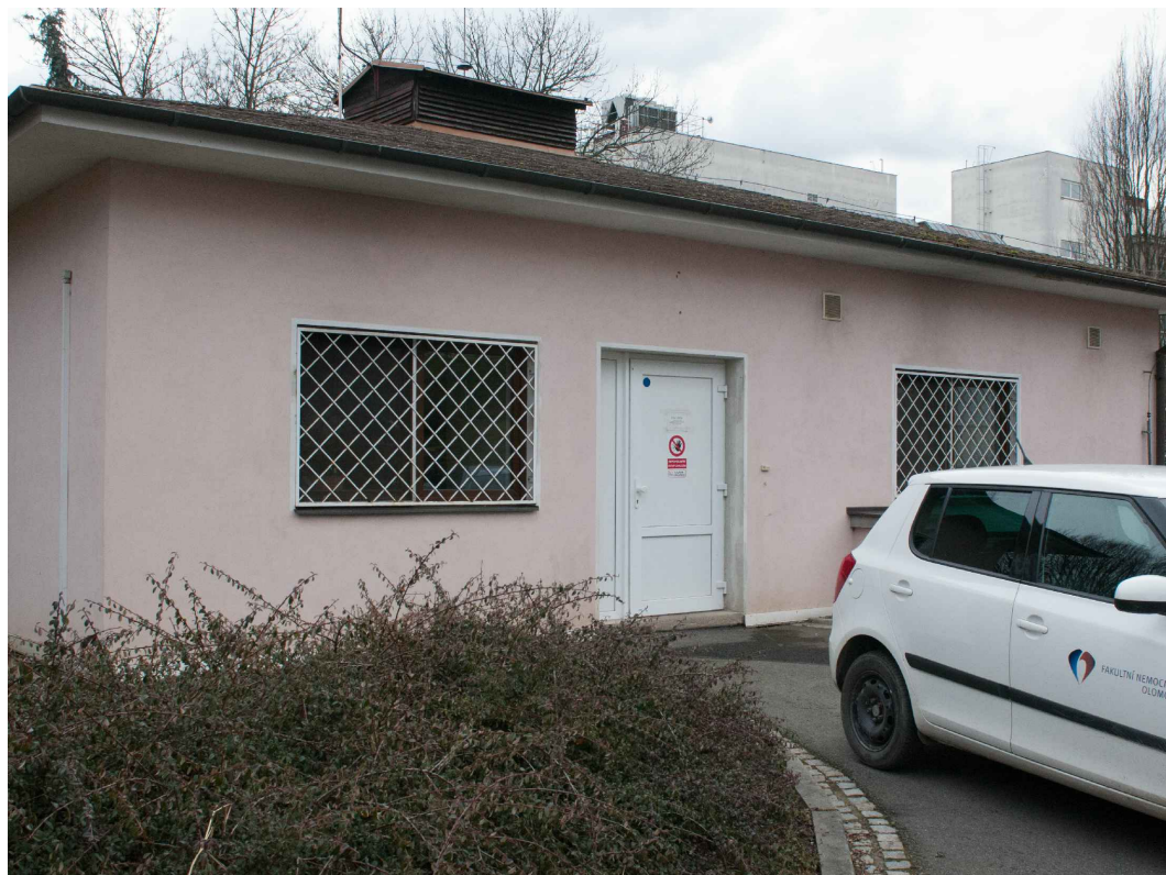
Budova XA - čistička odpadních vod - pohled ze severozápadu
