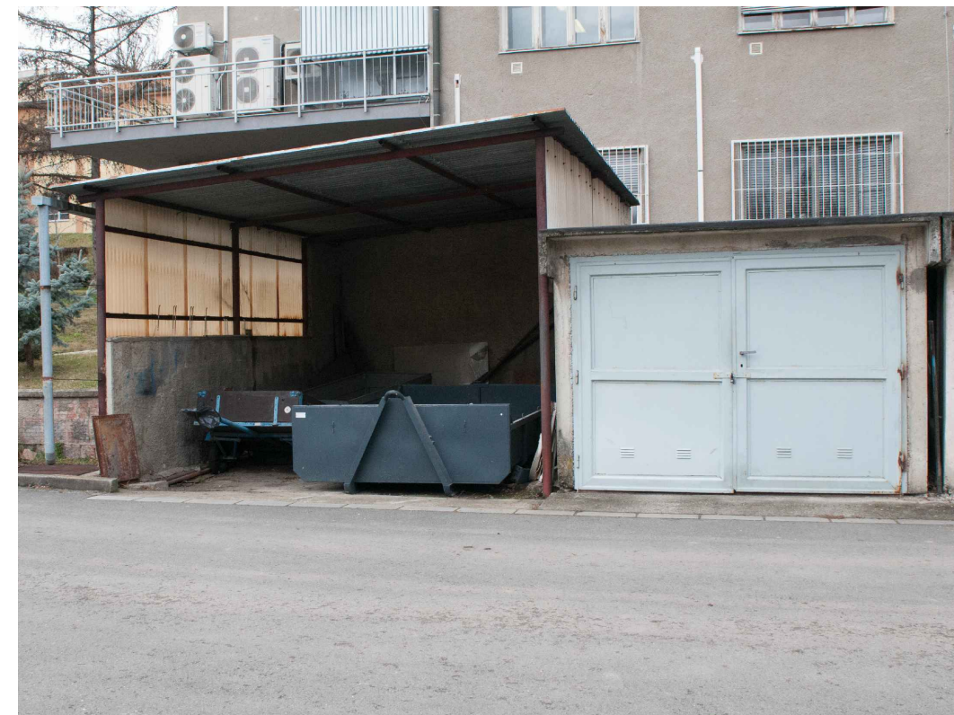
Budova XB - garáže - pohled z východu
