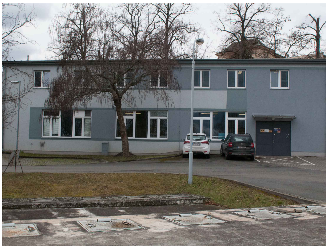
Budova XC - zámečnická dílna - pohled z východu
