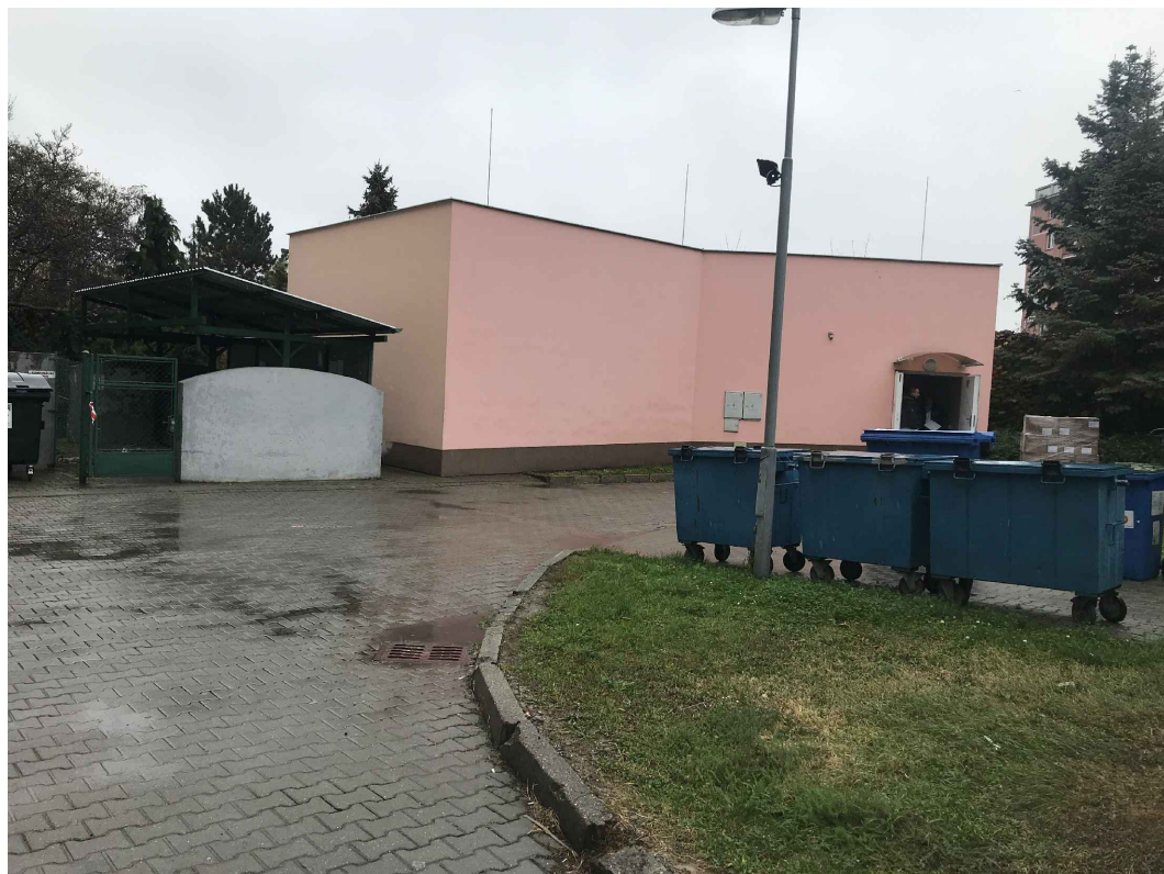
Budova XE - sklad, komorový mrazák - pohled z jihu
