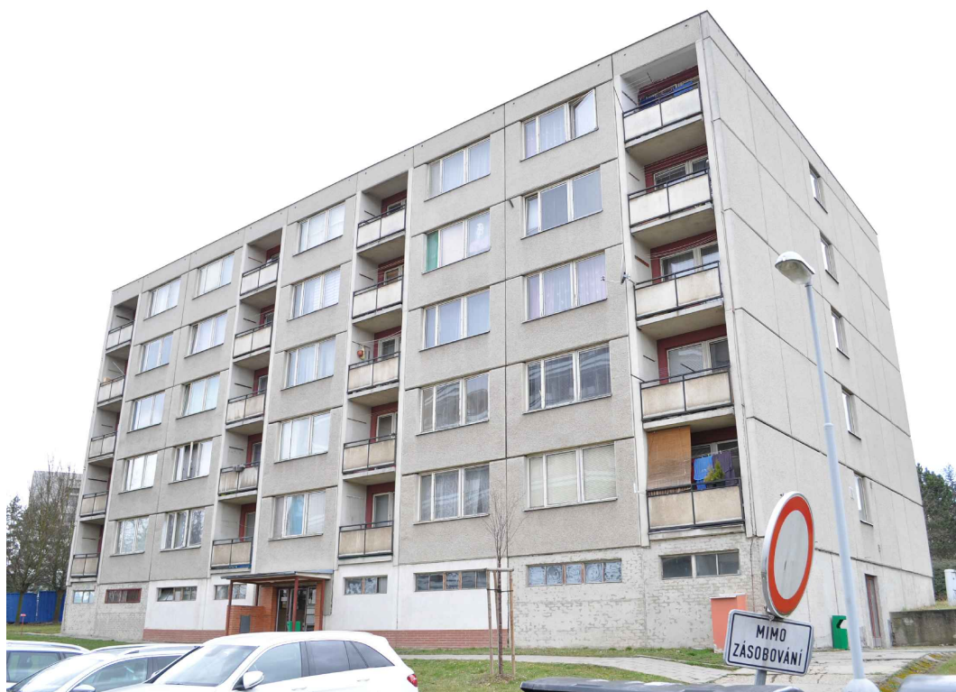
Budova YC - ubytování- pohled z východu
