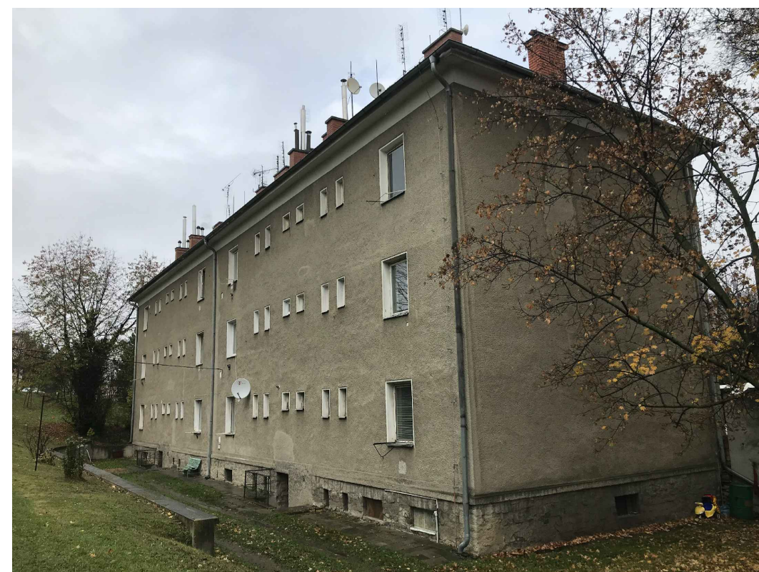
Budova YH - ubytovna - pohled z jihu
