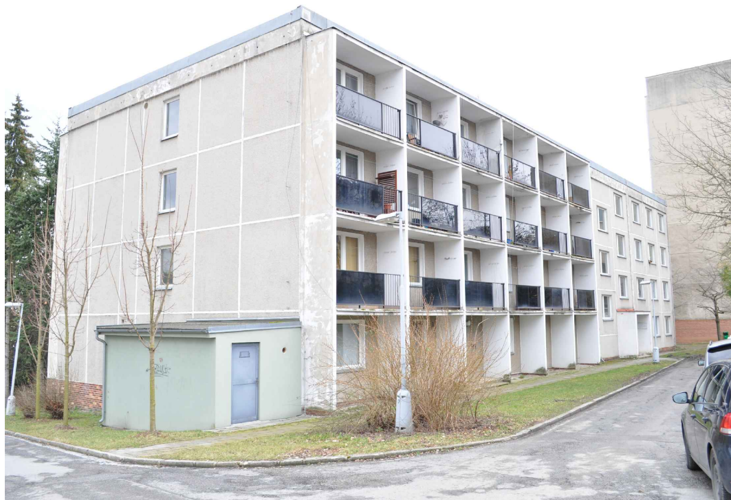
Budova YE - ubytovna - pohled ze severu
