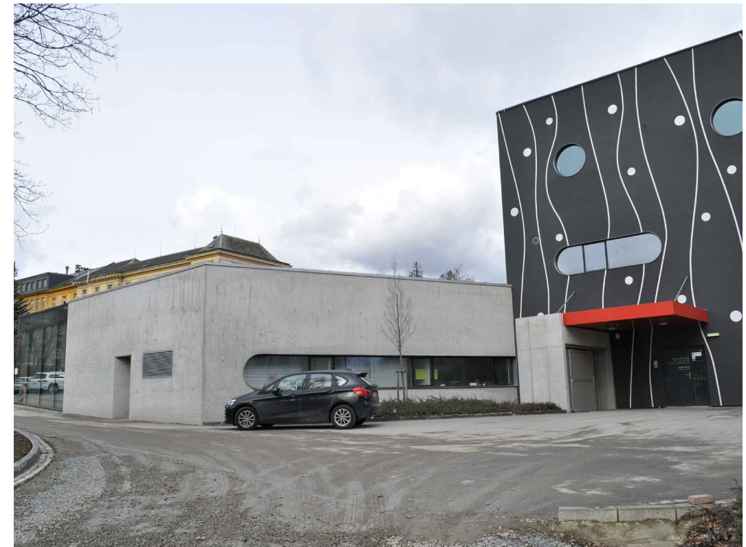
Budova Z - Lékárna - pohled z jihu
