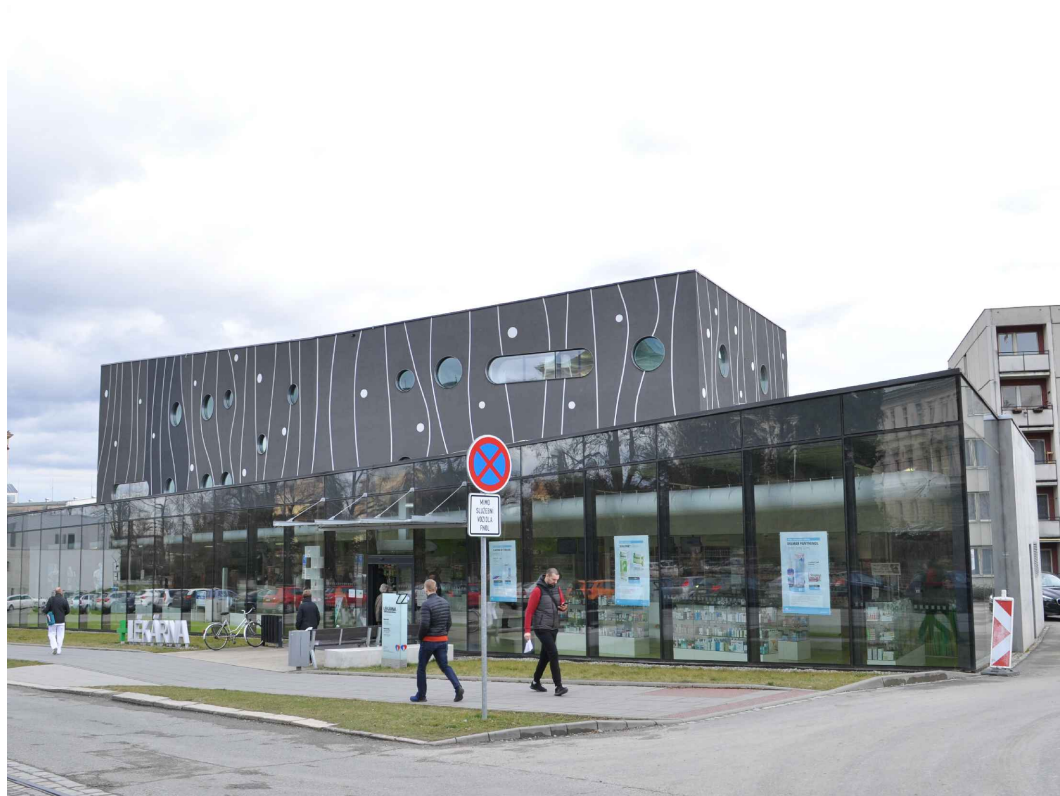
Budova Z - Lékárna - pohled ze severu
