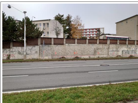
Foto 12 – Pohled na dilatační celek D÷C
