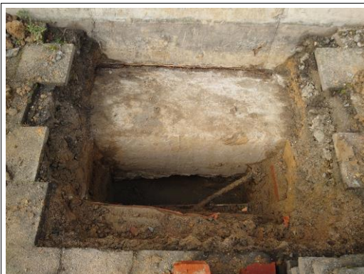
Foto 4 – Pohled na kopanou sondu KS-1
