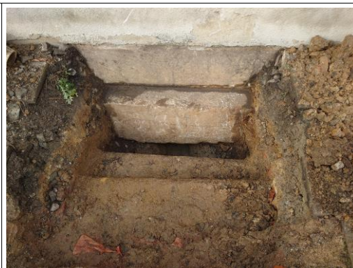
Foto 5 – Pohled na kopanou sondu KS-2
