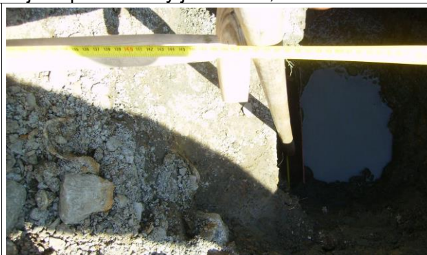
Foto 19 – Měření vzdálenosti od líce stěny
