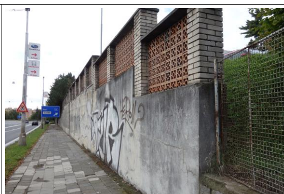
Foto 11 – Pohled od ulice Albertova – spodní část
