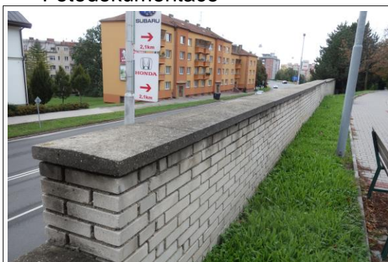
Foto 10 – Pohled za opěrnou stěnu – horní část
