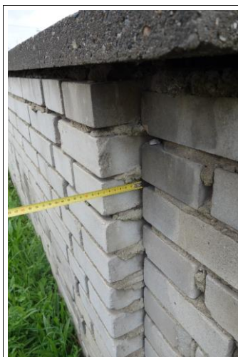
Foto 7 – Pohled na odklon C
