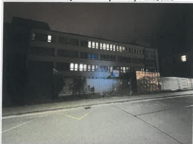
Obr./11/ Pohled na zdroje hluku - budova H2
