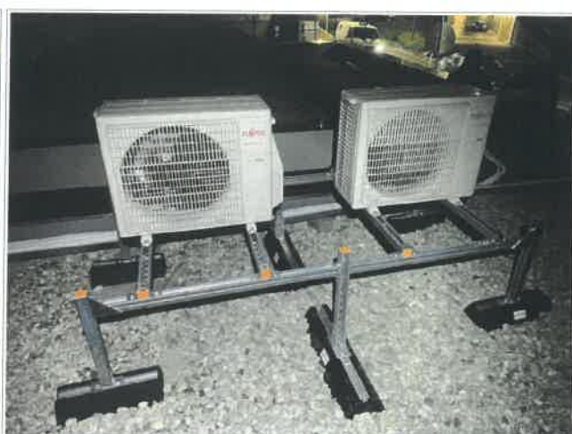
Obr./5/ Chladicí jednotky FUJITSU model AOYG07KETA
