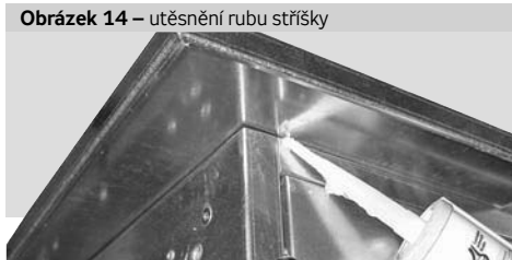
Obrázek 14 – utěsnění rubu stříšky
