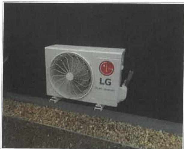
Obr./5/ Chladicí jednotka LG DUAL Inverter PC12SQUA3
