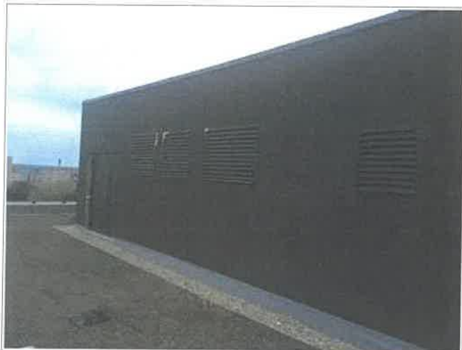
Obr./6/ Strojovna VZT umístěna na střeše přístavby pavilonu P
