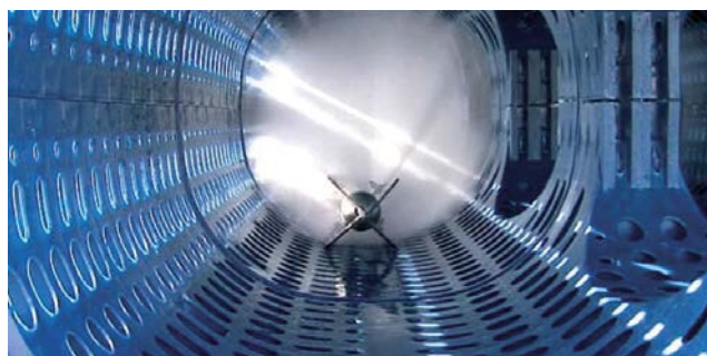
Tlakové čištění revizního kanálu v systému Q-Bic
