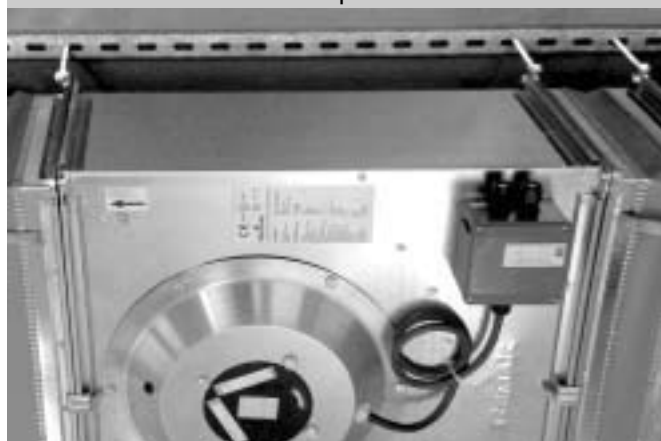
Obrázek 13 – zavěšení na pomocnou konstrukci
