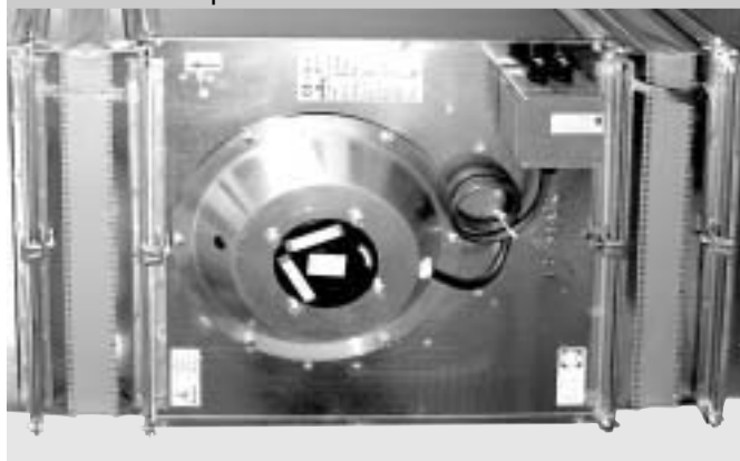
Obrázek 10 – použití tlumících vložek
