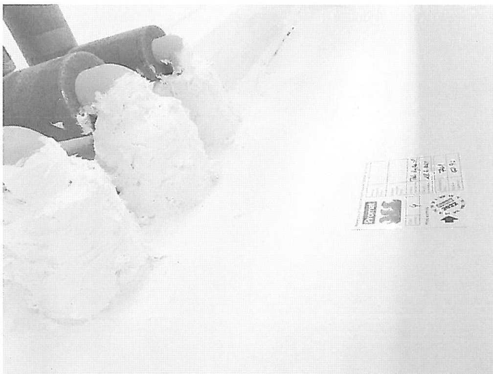
Požární ucpávka č.4 – prostup potrubí vodovodu
