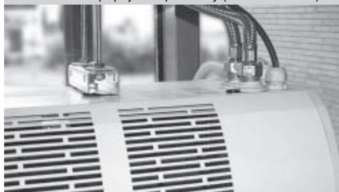
Obrázek 13 – připojení topné vody (ohebné hadice)
