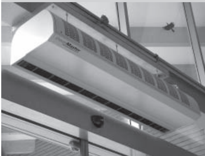
Obrázek 3 – instalace nad vchodové dveře
