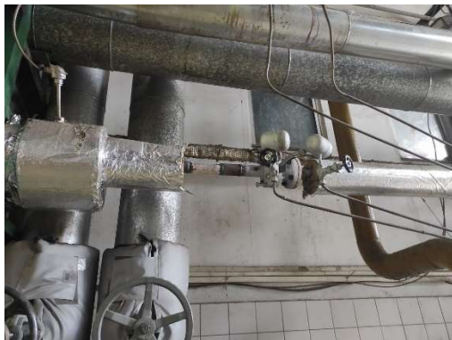
Doizolování měřící tratě
