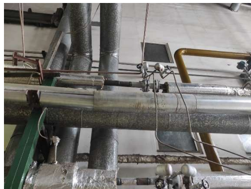
Doizolování měřící tratě
