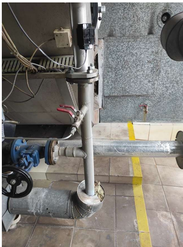
Doizolování potrubí napájecí vody
