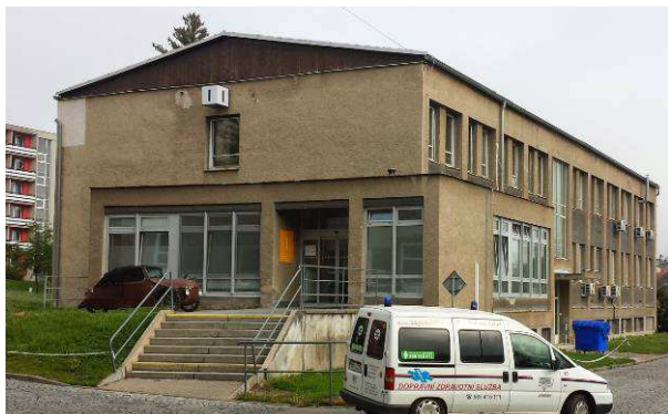
Vstup z ulice
