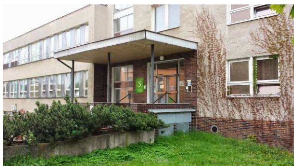
Vstup z ulice
