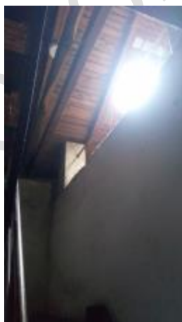
Obrázek 20 – Půda, střešní podbití
