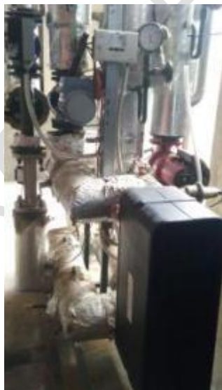
Obrázek 27 – 2x výměník pro ohřev vody pro OS
