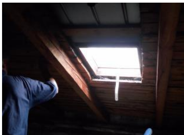
Obrázek 21 – Půda, střešní okno
