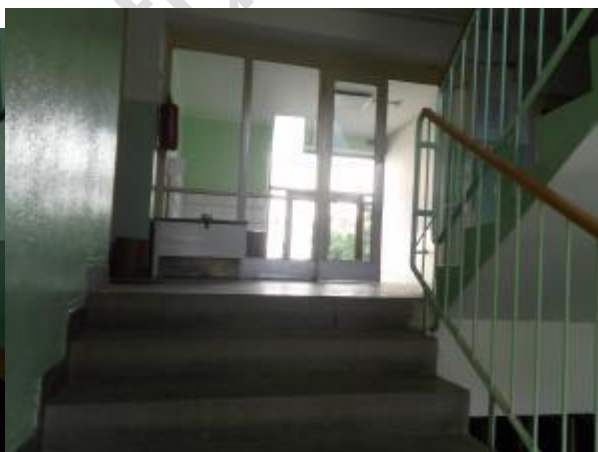
Obrázek 13 – Schodiště, chodba k bytovým jednotkám
