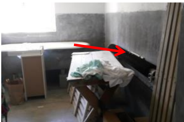
Obrázek 32 – Otopný registr s ,sušárna/ prádelna 1.PP
