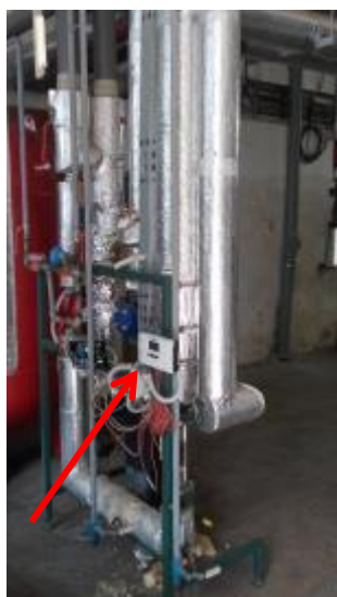
Obrázek 40–Kalorimetr Kamstrup pro měření tepla
