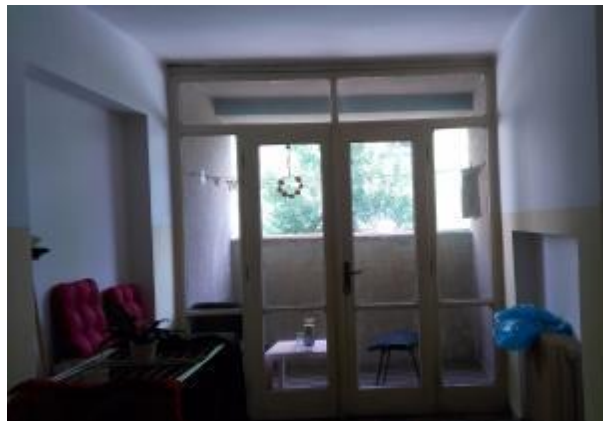
Obrázek 15 – Chodba k bytovým jednotkám, lodžie
