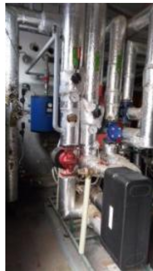
Obrázek 28 – 2x výměník pro ohřev vody pro OS
