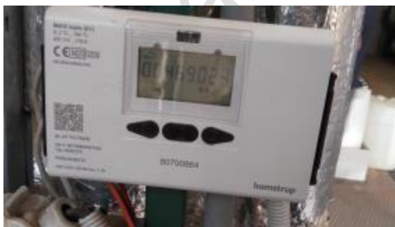
Obrázek 41–Kalorimetr Kamstrup pro měření tepla
