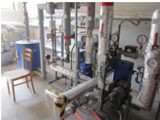
Obrázek 15–Předávací stanice OPS YC
