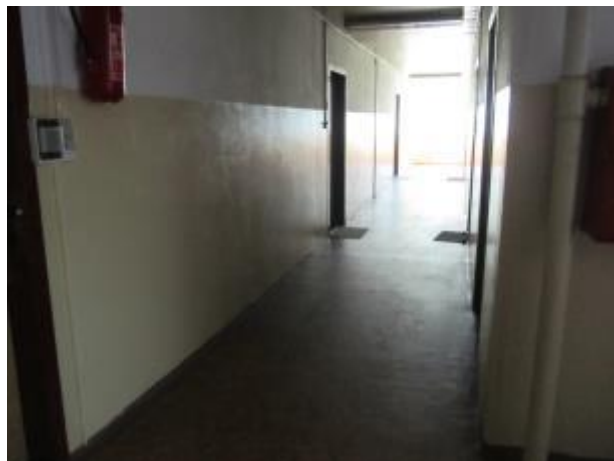
Obrázek 11 – Chodba k bytům, vytápěno
