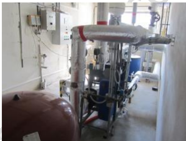
Obrázek 16–Předávací stanice OPS YC
