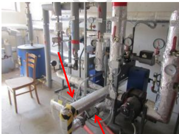
Obrázek 26–Umístění kalorimetru v OPS YC
