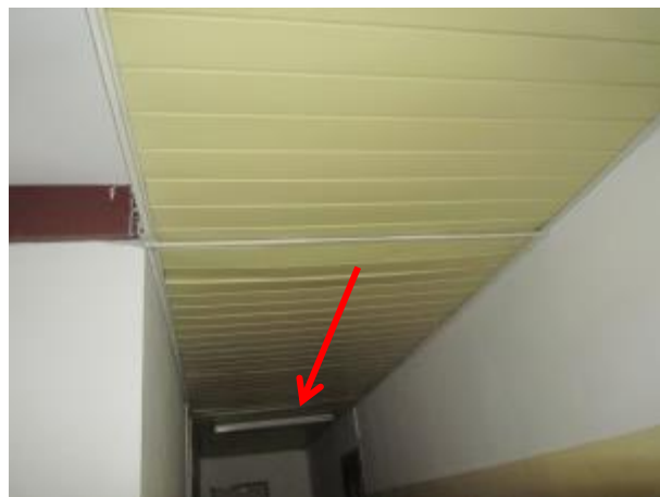
Obrázek 24–Žářivkové trubicové svítidlo, společné prostory
