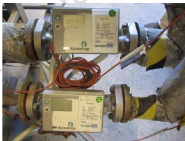
Obrázek 29 – Kalorimetr pro měření tepla
