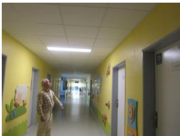
Obrázek 57 – Nová LED úsporná svítidla obdélníková v pohledu, chodba v objektu Q2
