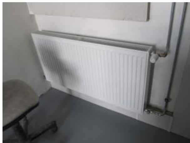
Obrázek 29 – Deskové ocelové OT, objekt Q2
