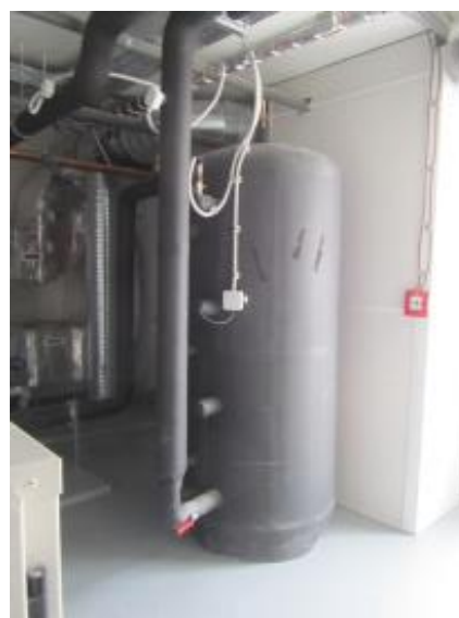
Obrázek 50 – Akumulační nádoba 1000l
