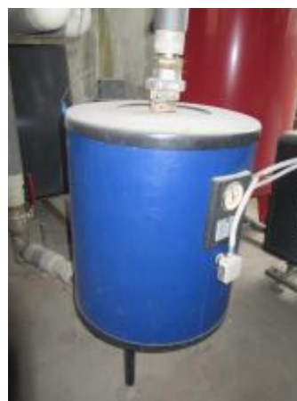
Obrázek 34 – Pohotovostní zásobník teplé vody ANTIKOR AKU 100
