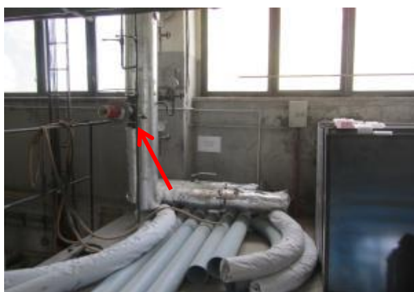
Obrázek 27 – Hlavní uzávěr horkovodu
