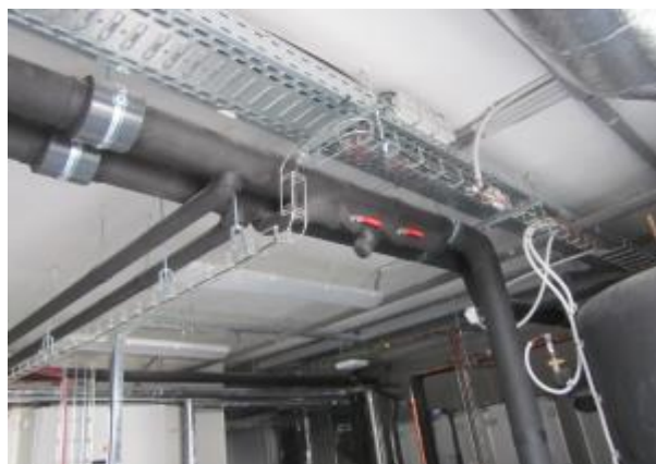
Obrázek 55 – Klasická zářivková trubicová svítidla 2x 36W, strojovna chlazení na objektu Q2
