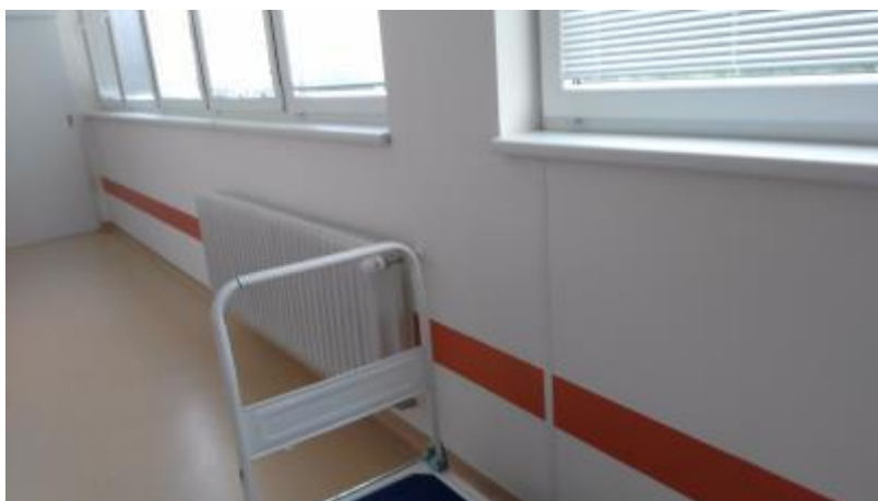
Obrázek 30 – Deskové ocelové OT, objekt Q1
