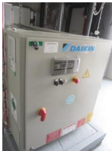
Obrázek 48 – Chladicí jednotka DAIKIN EW-LD110J-SS034
