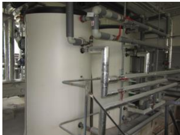
Obrázek 32 – 2x smaltovaný zásobníkový ohřivač TV
