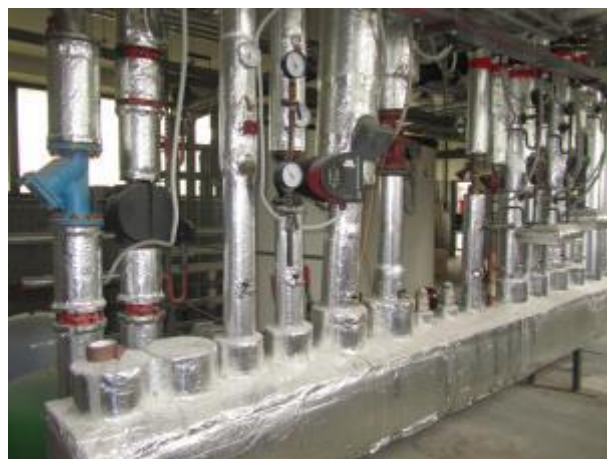
Obrázek 26 – Rozdělovač a sběrač topné vody
