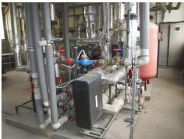
Obrázek 25 – Tepelné výměníky ALFA LAVAL typ CB110-90M
