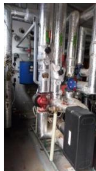
Obrázek 28 – 2x výměník pro ohřev vody pro OS
