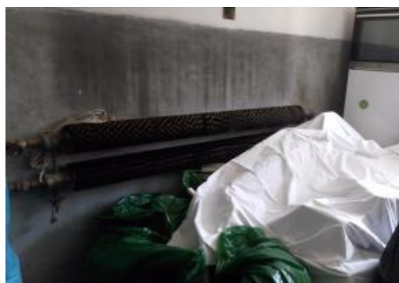
Obrázek 31 – Otopný registr s lamelami, sušárna 1.PP
