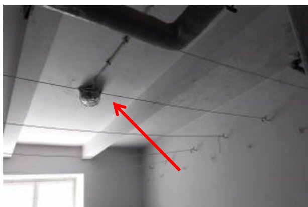
Obrázek 37–Žárovkové svítidlo, suterén
