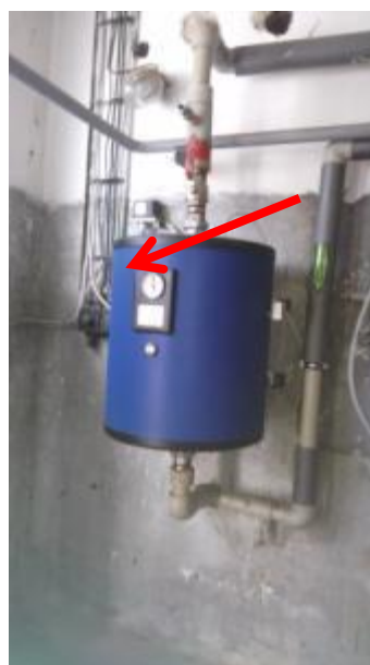
Obrázek 35– Stojatá AN Antikor AKU 100S
