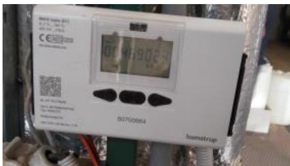
Obrázek 41–Kalorimetr Kamstrup pro měření tepla
