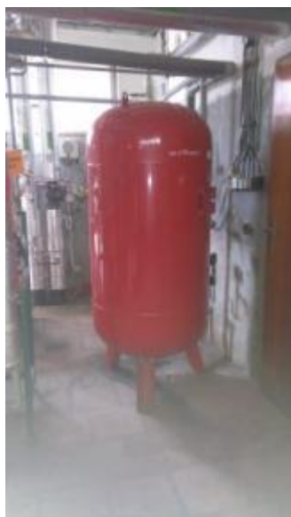
Obrázek 29 – Expanzní nádoba MAXIVAREM LS
