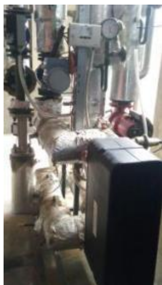
Obrázek 27 – 2x výměník pro ohřev vody pro OS
