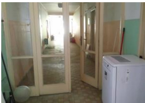
Obrázek 14 – Chodba k bytovým jednotkám
