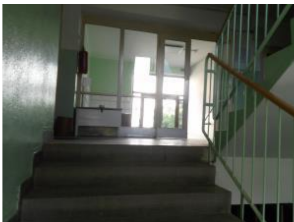
Obrázek 13 – Schodiště, chodba k bytovým jednotkám
