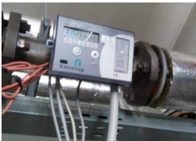
Obrázek 39–Kalorimetr Kamstrup pro měření tepla
