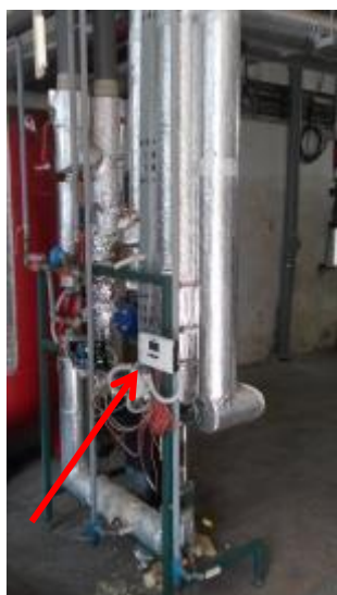
Obrázek 40–Kalorimetr Kamstrup pro měření tepla
