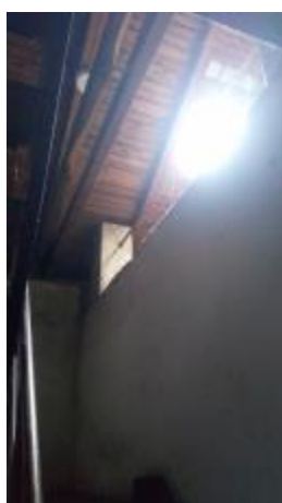
Obrázek 20 – Půda, střešní podbití
