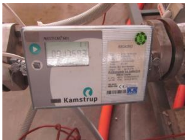
Obrázek 27–Kalorimetr Kamstrup MULTICAL pro měření tepla
