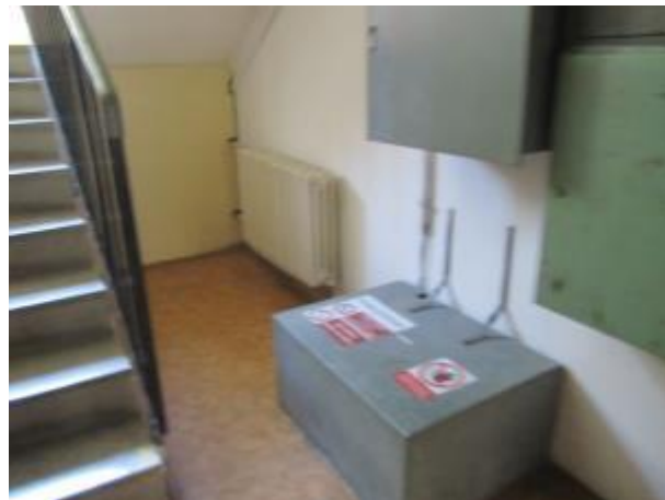
Obrázek 19 – Článkové OT, chodba vstup
