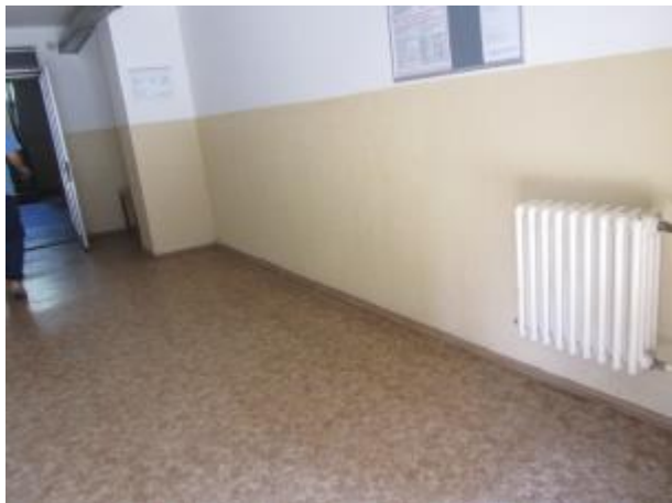
Obrázek 18 – Článkové OT, chodba vstup
