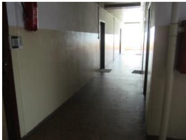
Obrázek 11 – Chodba k bytům, vytápěno
