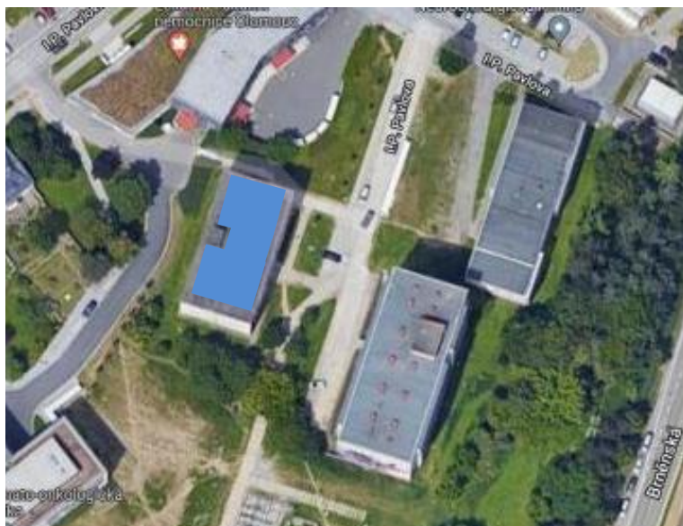
Obrázek 36 – Využitelný prostor střechy pro umístění FV panelů
