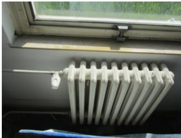
Obrázek 21 – OT s TRV a TRH, na chodbě k bytům
