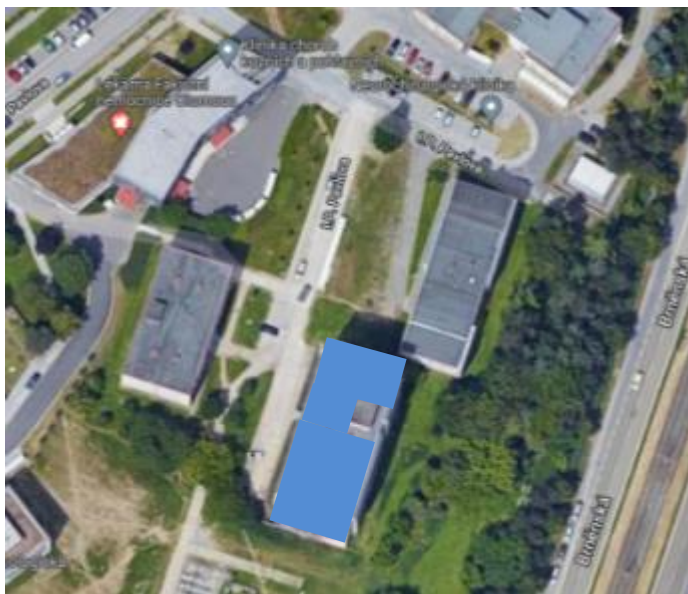
Obrázek 41 – Využitelný prostor střechy pro umístění FV panelů
