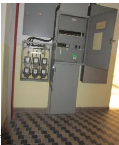
Obrázek 32 – Podružná měřidla na chodbě objektu
