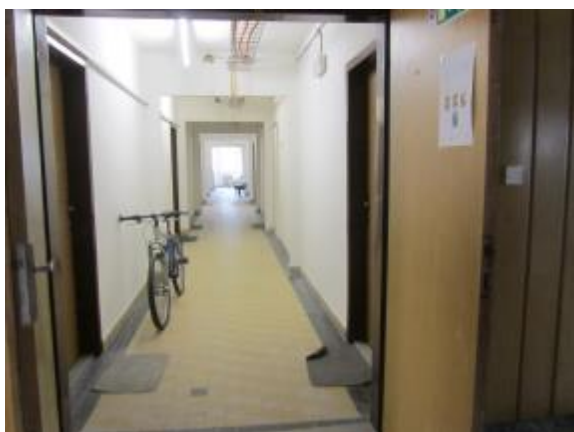
Obrázek 14 – Chodba k bytovým jednotkám, 1. NP
