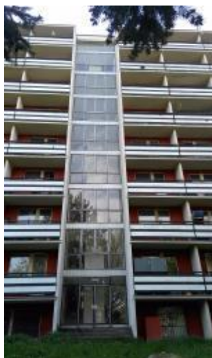
Obrázek 8 – Jihovýchodní pohled, schodiště
