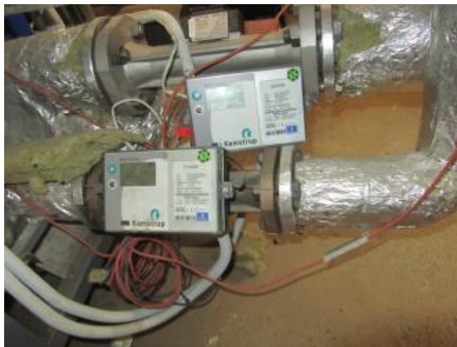
Obrázek 28–Kalorimetr pro měření tepla
