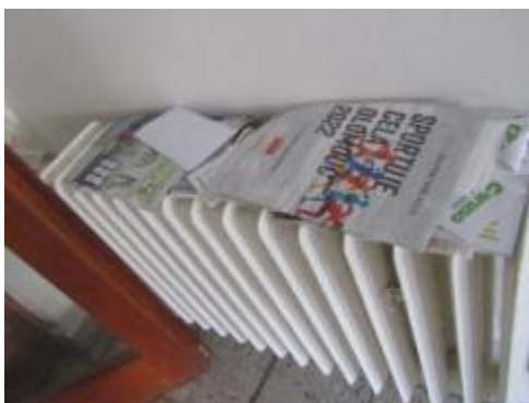
Obrázek 22 – Článkové otopné těleso
