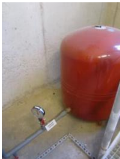
Obrázek 18 – Expanzní nádoba Reflex N
