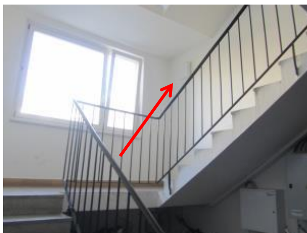
Obrázek 26 – Žárovkové svítidlo, schodiště
