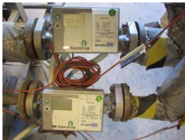
Obrázek 29 – Kalorimetr pro měření tepla
